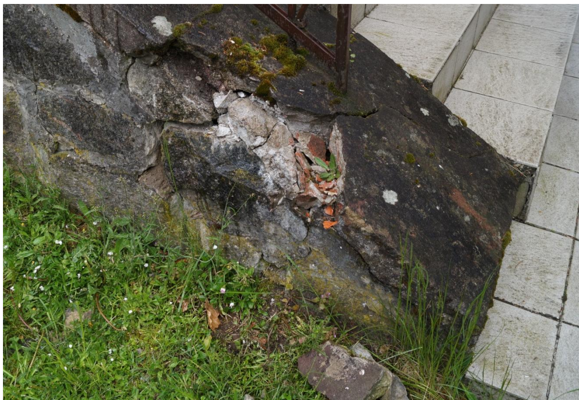
Fot. 32 i 33 (wyk. mgr W. Tomaszewski): Widok stanu zachowania schodów prowadzących do pomieszczenia werandy. Powierzchnię schodów obecnie w całości pokrywają kafle ceramiczne (gres). Widoczne jest uszkodzenie betonowej wylewki, w którą zakotwiona jest metalowa balustrada.
