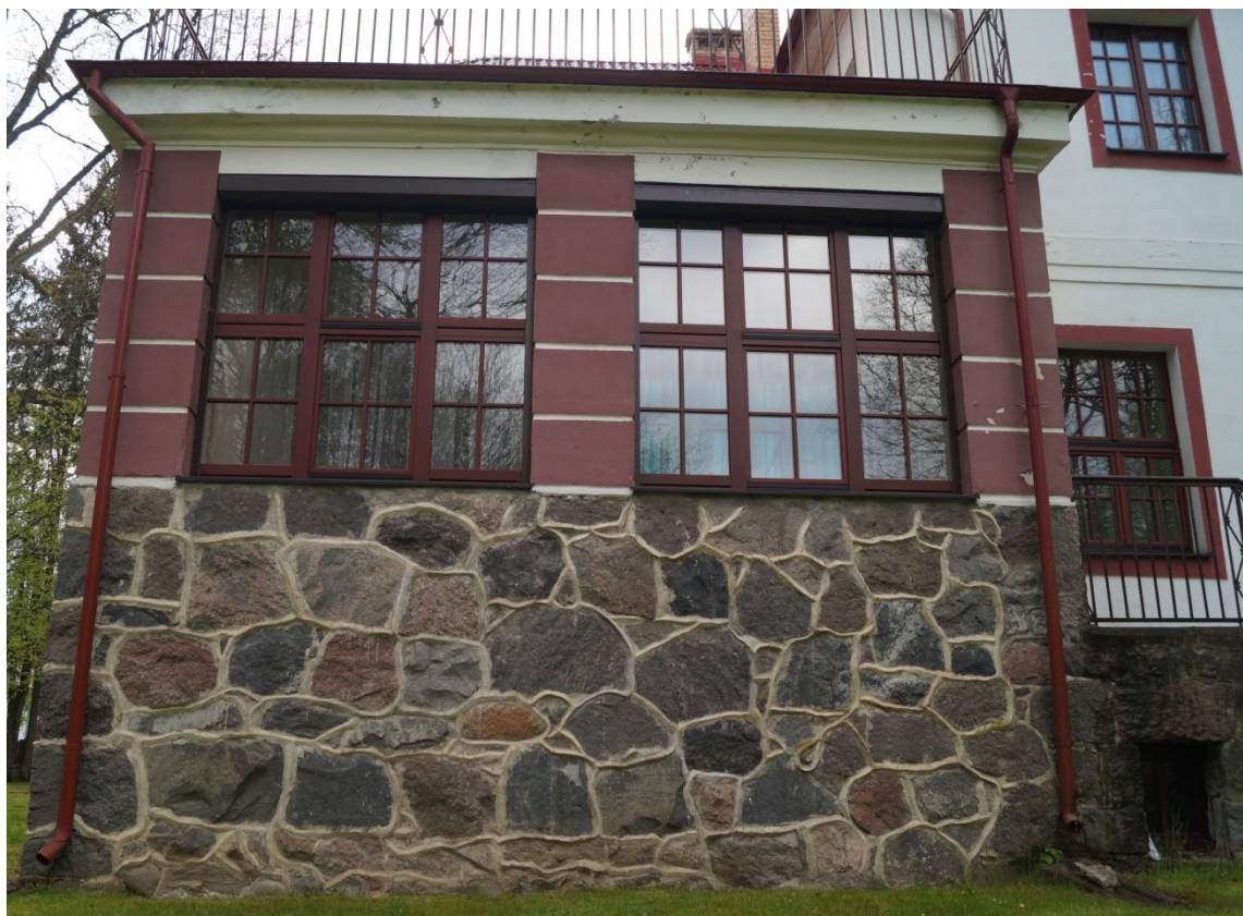
Fot. 28 i 29 (wyk. mgr W. Tomaszewski): Widok stanu zachowania werandy z tarasem. Kamienne cokoły pod werandą są wtórnie wyspoinowane – w charakterystyczny ostry sposób ukształtowania spoin.
