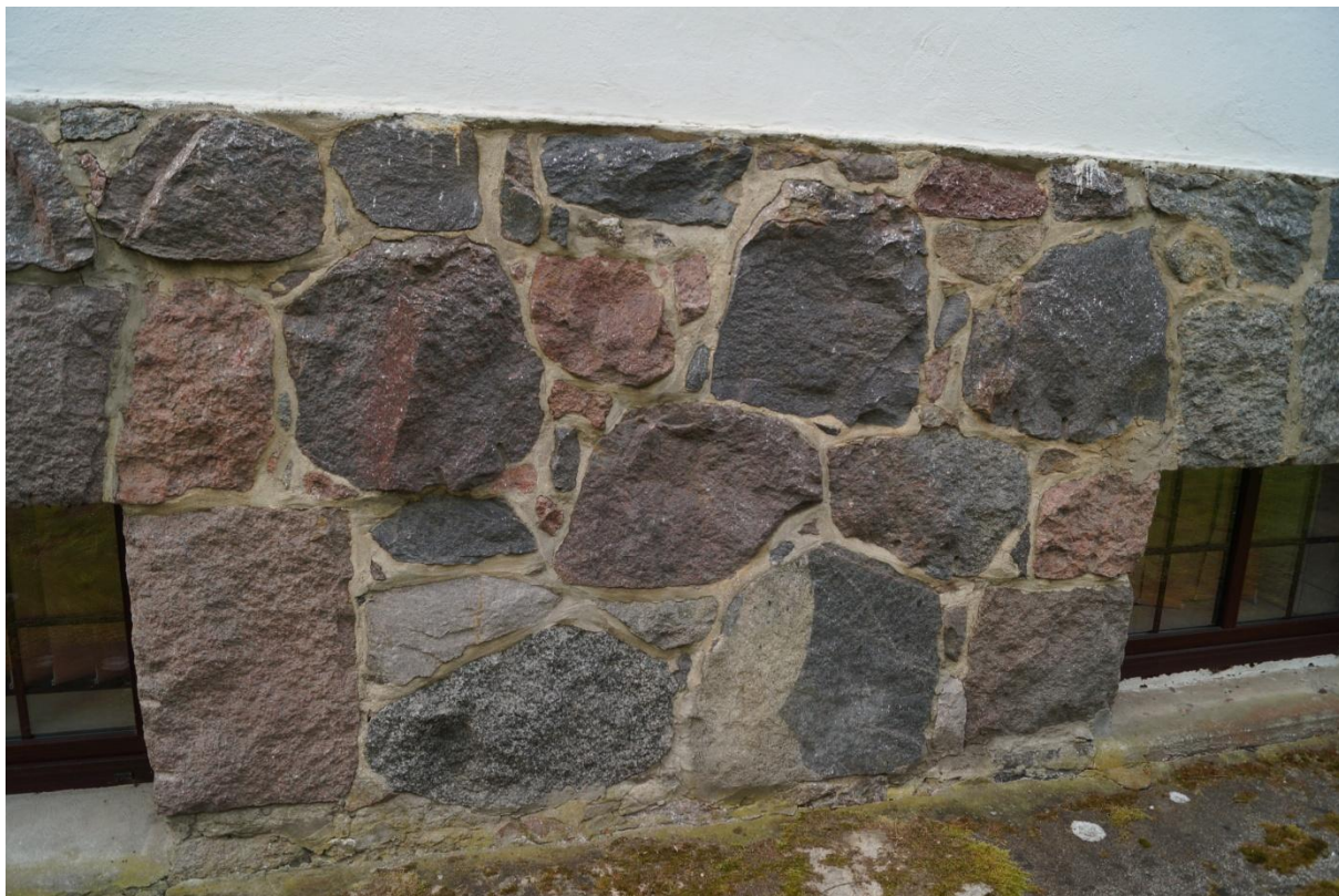
Fot. 46 (wyk. mgr W. Tomaszewski): Przykład zróżnicowanego spoinowania na wybranym fragmencie muru po stronie elewacji południowej.
