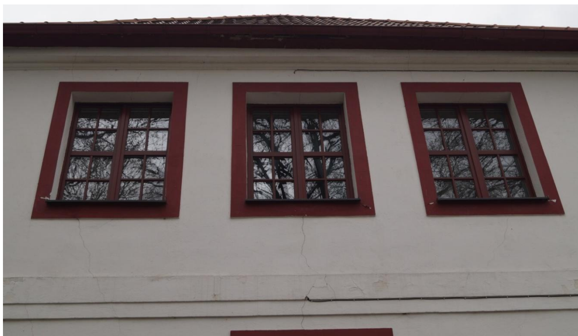
Fot. 37 (wyk. mgr W. Tomaszewski): Widok drobnych rys przechodzących pod lewym i środkowym oknem w kierunku gzymsu między-kondygnacyjnego.
