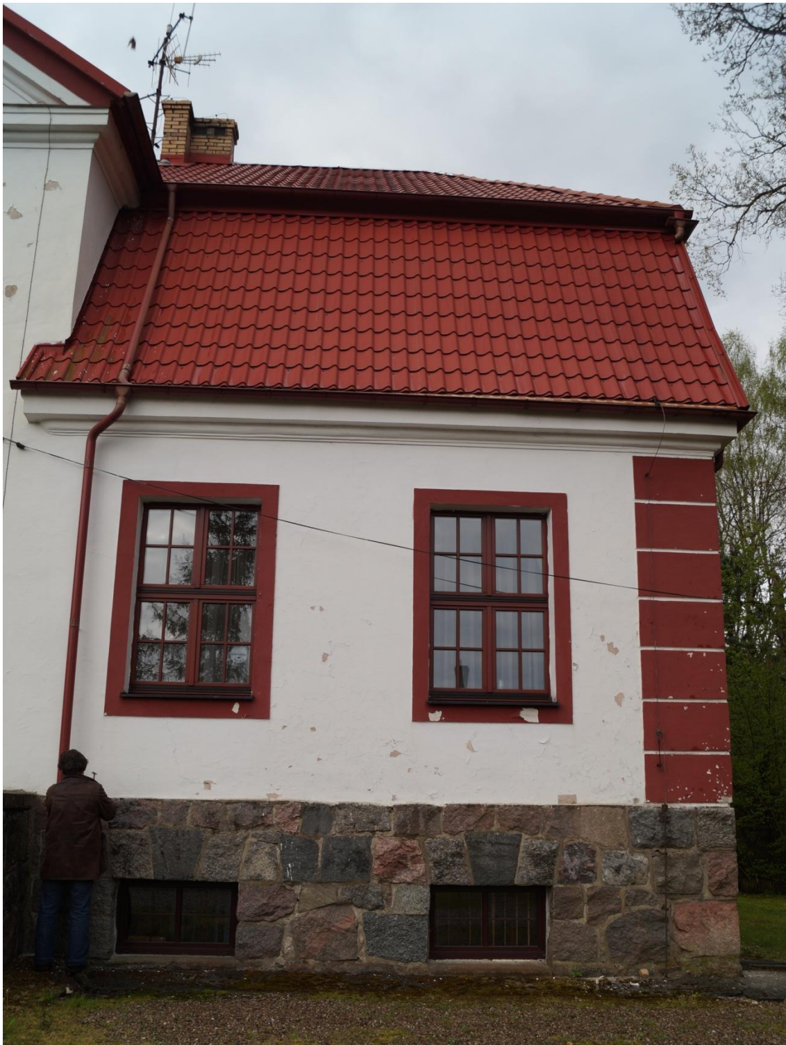
Fot. 11 (wyk. mgr W. Tomaszewski): Widok skrajnych osi elewacji zachodniej, ukazujący stan zachowania fragmentu kamiennego cokołu, opasek okiennych, narożnych boniowań oraz odcinka profilowanego gzymsu pod okapem dachu i rynną. Farba na elewacji w wielu miejscach złuszcza się i odpada. W wielu miejscach zlokalizowano pustki, odparzenia oraz wypłukania warstw tynkarskich. Jest to zachodnia strona elewacji, która jest najbardziej narażona na wiatry oraz zacinające deszcze – co potwierdza mieszkający w budynku Leśniczy.
