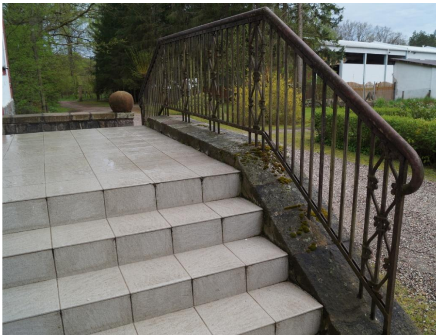
Fot. 58 i 59 (wyk. mgr W. Tomaszewski): Widok stanu zachowania oryginalnych stalowych balustrad osadzonych w murze kamiennym przy schodach lustrzanych – po zachodniej stronie elewacji.
