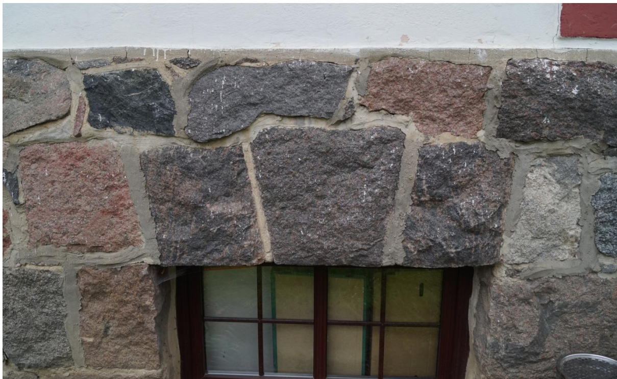
Fot. 38 i 39 (wyk. mgr W. Tomaszewski): Przykład występowania różnorodnych spoin na wybranym fragmencie powierzchni muru ceglanego z jednoczesnym wskazaniem odcinka oryginalnej spoiny (elewacja wschodnia).
