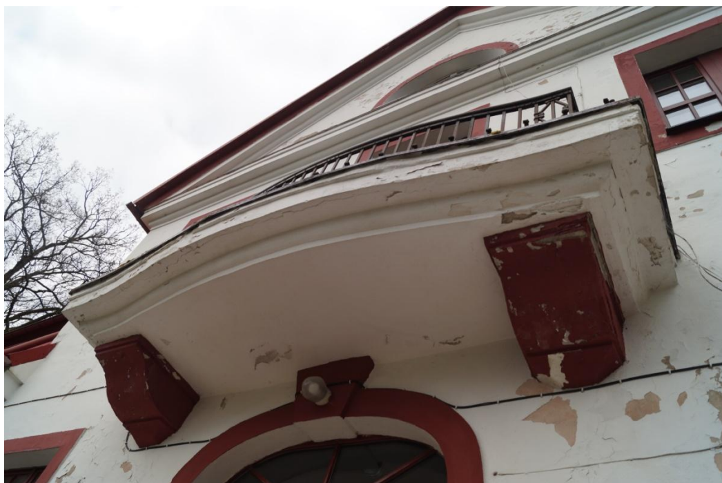
Fot. 8 i 9 (wyk. mgr W. Tomaszewski): Widok stanu zachowania wnęki wejściowej (portalu), wtórnych drzwi drewnianych oraz balkonu opartego na dekoracyjnych wspornikach. Farba na elewacji w wielu miejscach złuszcza się i odpada. W wielu miejscach zlokalizowano pustki, odparzenia oraz wypłukania warstw tynkarskich. Jest to zachodnia strona elewacji, która jest najbardziej narażona na wiatry oraz zacinające deszcze – co potwierdza mieszkający w budynku Leśniczy.
