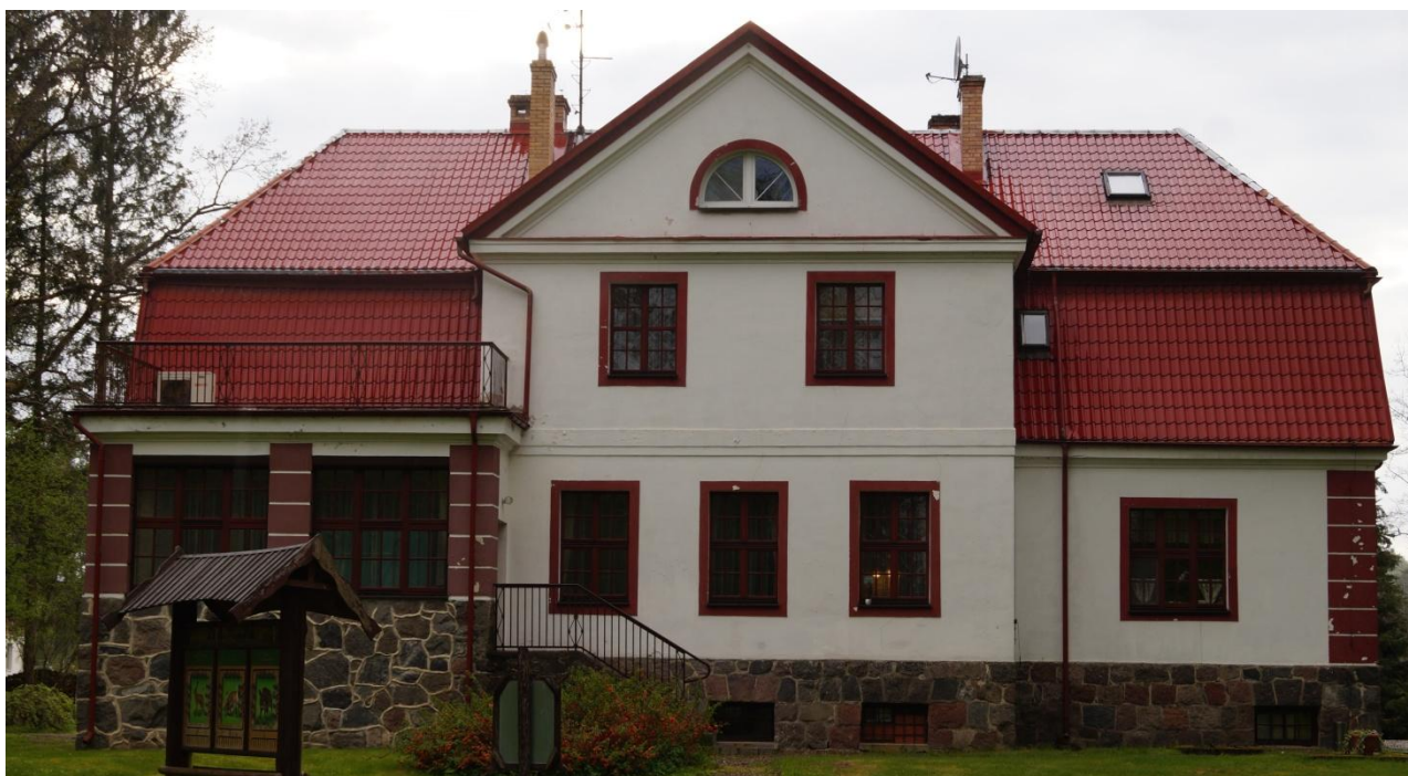
Fot. 24 i 25 (wyk. mgr W. Tomaszewski): Widok ogólny elewacji wschodniej od strony stawu z dwukondygnacyjnym ryzalitem zwieńczonym trójkątnym szczytem oraz werandą na wysokim kamiennym cokole, zwieńczoną tarasem. Dekorację elewacji stanowią kamienny cokół oraz występujące detale architektoniczne, takie jak: profilowane gzymsy, narożne boniowania i proste opaski okienne. Całość obecnej stolarki okiennej jest wtórna. Są to okna drewniane z szybami zespolonymi (1 okno PCV). Stolarka drzwiowa zewnętrzna również jest wtórna. Metalowe balustrady obecne na tarasie i schodach są wtórne.
