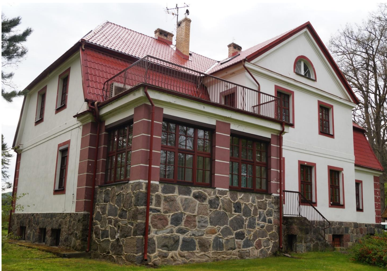
Fot. 24 i 25 (wyk. mgr W. Tomaszewski): Widok ogólny elewacji wschodniej od strony stawu z dwukondygnacyjnym ryzalitem zwieńczonym trójkątnym szczytem oraz werandą na wysokim kamiennym cokole, zwieńczoną tarasem. Dekorację elewacji stanowią kamienny cokół oraz występujące detale architektoniczne, takie jak: profilowane gzymsy, narożne boniowania i proste opaski okienne. Całość obecnej stolarki okiennej jest wtórna. Są to okna drewniane z szybami zespolonymi (1 okno PCV). Stolarka drzwiowa zewnętrzna również jest wtórna. Metalowe balustrady obecne na tarasie i schodach są wtórne.
