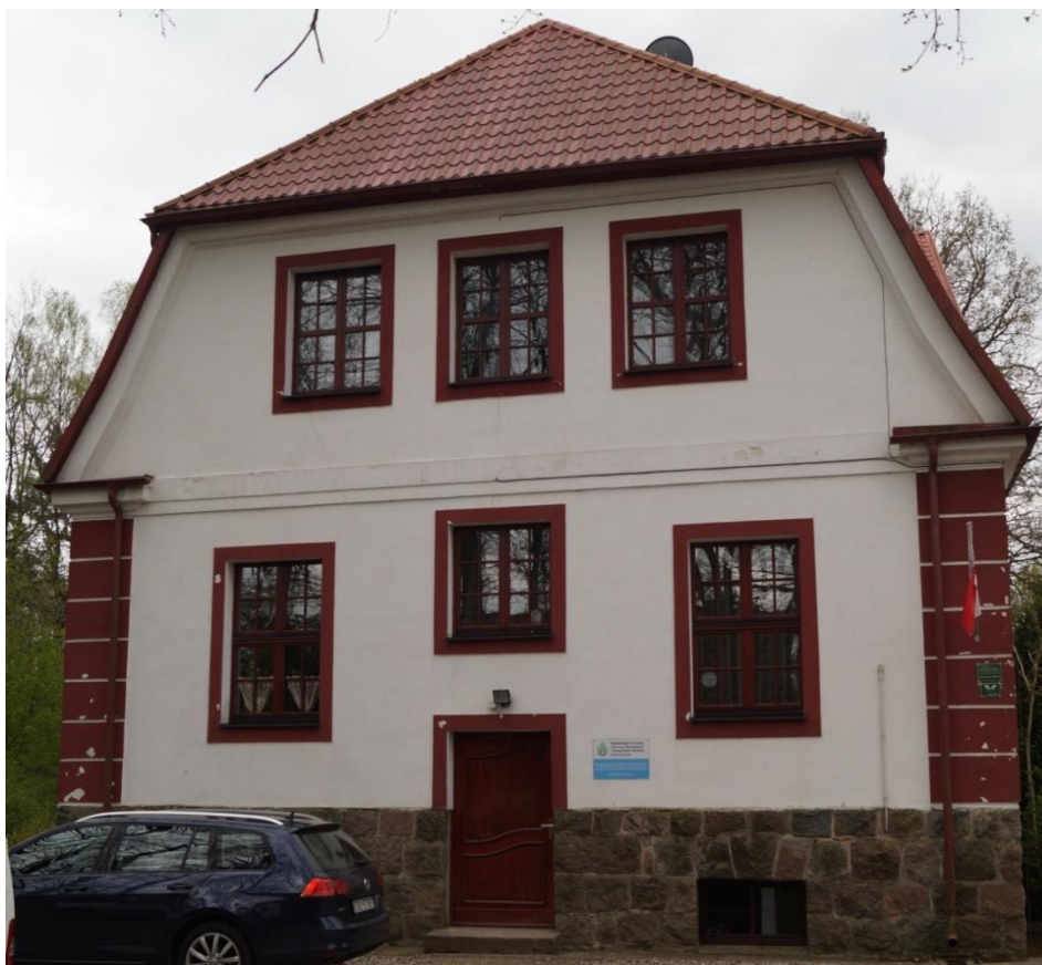
Fot. 36 (wyk. mgr W. Tomaszewski): Widok elewacji północnej ukazujący stan zachowania fragmentu kamiennego cokołu, opasek okiennych, narożnych boniowań oraz odcinków profilowanych gzymsów oddzielających kondygnację oraz obwodzących dach. Farba na elewacji w kilku miejscach złuszcza się i odpada. Zlokalizowano także pustki pod warstwami tynkarskimi oraz drobne rysy.
