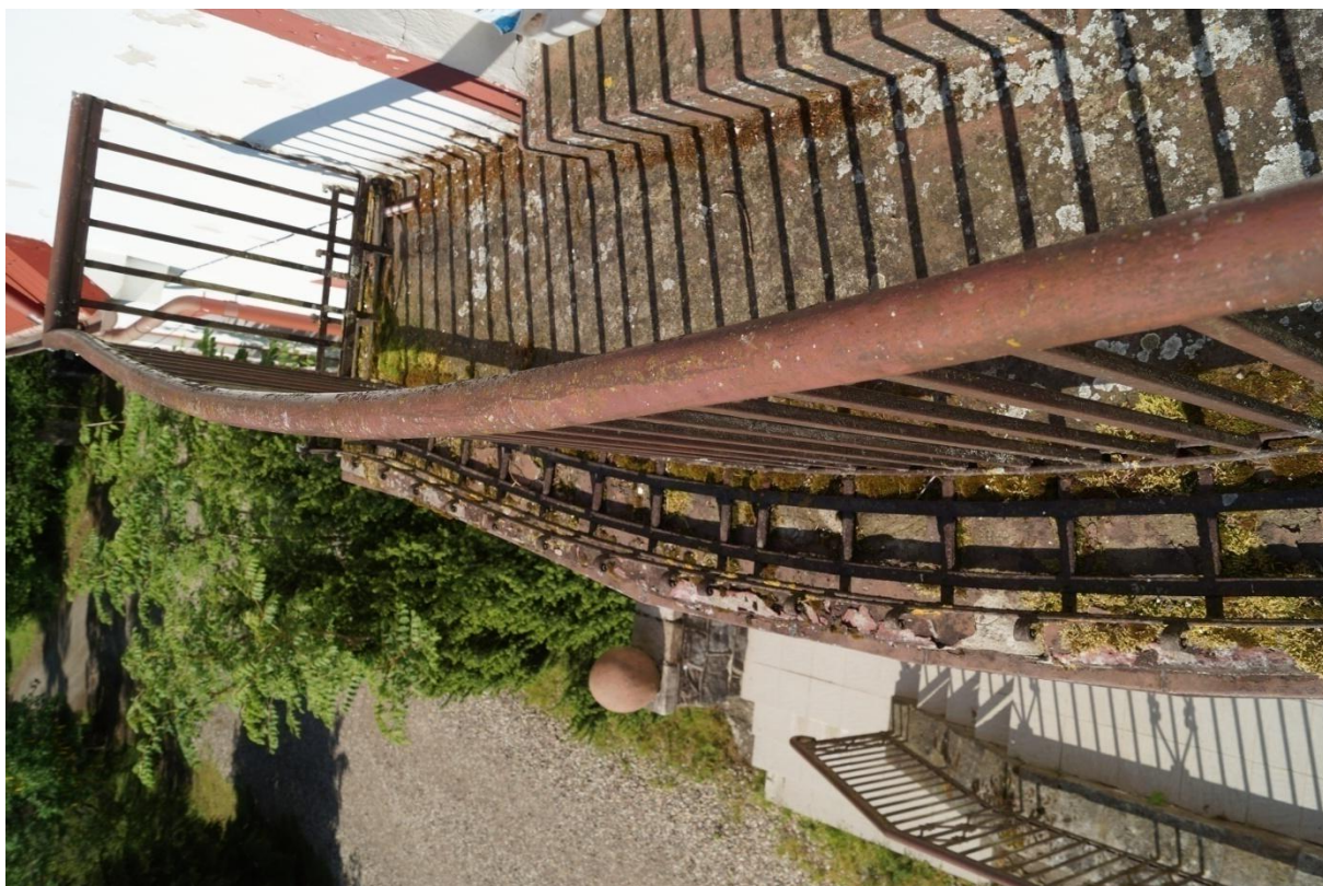
Fot. 62 i 63 (wyk. mgr W. Tomaszewski): Widok stanu zachowania oryginalnej stalowej balustrady osadzonej w rdzeniu płyty balkonowej – po zachodniej stronie elewacji.
