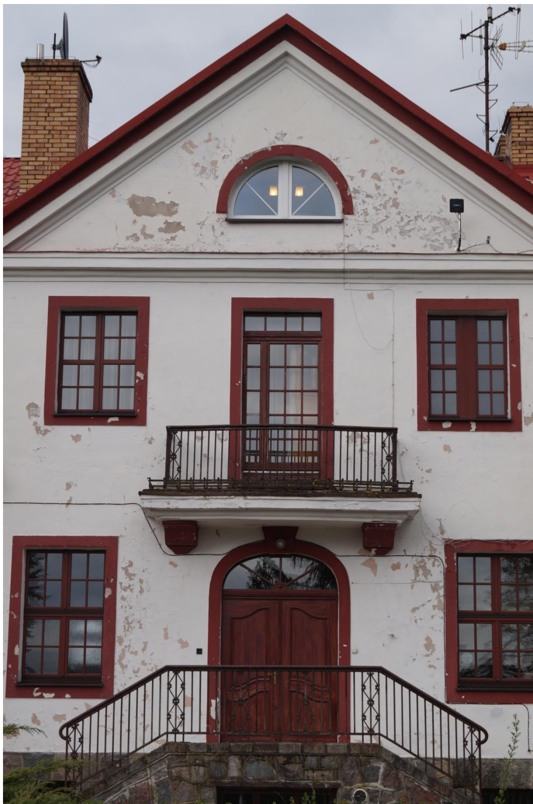
Fot. 10 (wyk. mgr W. Tomaszewski): Widok środkowych osi elewacji zachodniej, ukazujący stan zachowania fragmentu kamiennego cokółu, oryginalnej metalowej balustrady, wnęki wejściowej (portalu), wtórnych drzwi drewnianych oraz balkonu opartego na dekoracyjnych wspornikach wraz z oryginalną metalową balustradą. Farba na elewacji w wielu miejscach złuszcza się i odpada. W wielu miejscach zlokalizowano pustki, odparzenia oraz wypłukania warstw tynkarskich. Jest to zachodnia strona elewacji, która jest najbardziej narażona na wiatry oraz zacinające deszcze – co potwierdza mieszkający w budynku Leśniczy.
