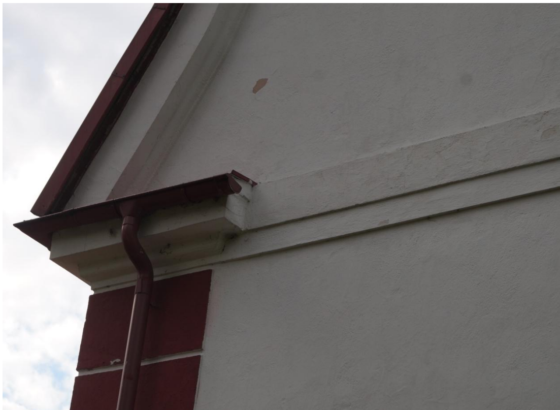
Fot. 19 i 20 (wyk. mgr W. Tomaszewski): Widok stanu zachowania odcinków profilowanych gzymsów na elewacji południowej. W kilku miejscach farba złuszcza się i odspaja. Zlokalizowano również pustki pod warstwami tynkarskimi.
