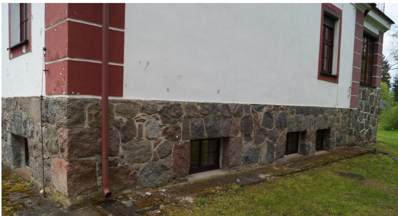
Fot. 17 i 18 (wyk. mgr W. Tomaszewski): Widok elewacji południowej, ukazujący stan zachowania fragmentu kamiennego cokotu, opasek okiennych, narożnych boniowań oraz odcinków profilowanych gzymsów oddzielających kondygnację oraz obwodzących dach. Farba na elewacji w kilku miejscach złuszcza się i odpada. Zlokalizowano także nieliczne pustki pod warstwami tynkarskimi.
