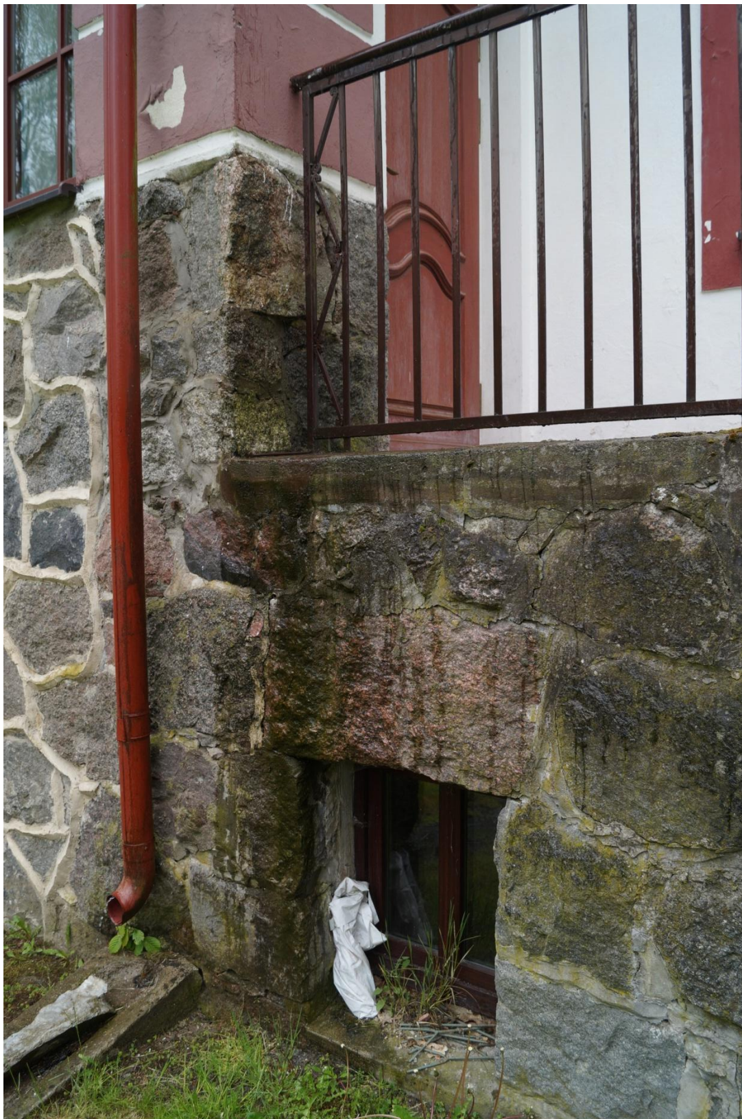
Fot. 31 (wyk. mgr W. Tomaszewski): Widok zacieków spowodowanych nieuszczelnością rynny. Zjawisko sprzyja rozwojowi glonów na powierzchniach bloków granitowych. Metalowe balustrady na schodach są wtórne. Drewniane drzwi wejściowe pomieszczenia werandy są również wtórne.
