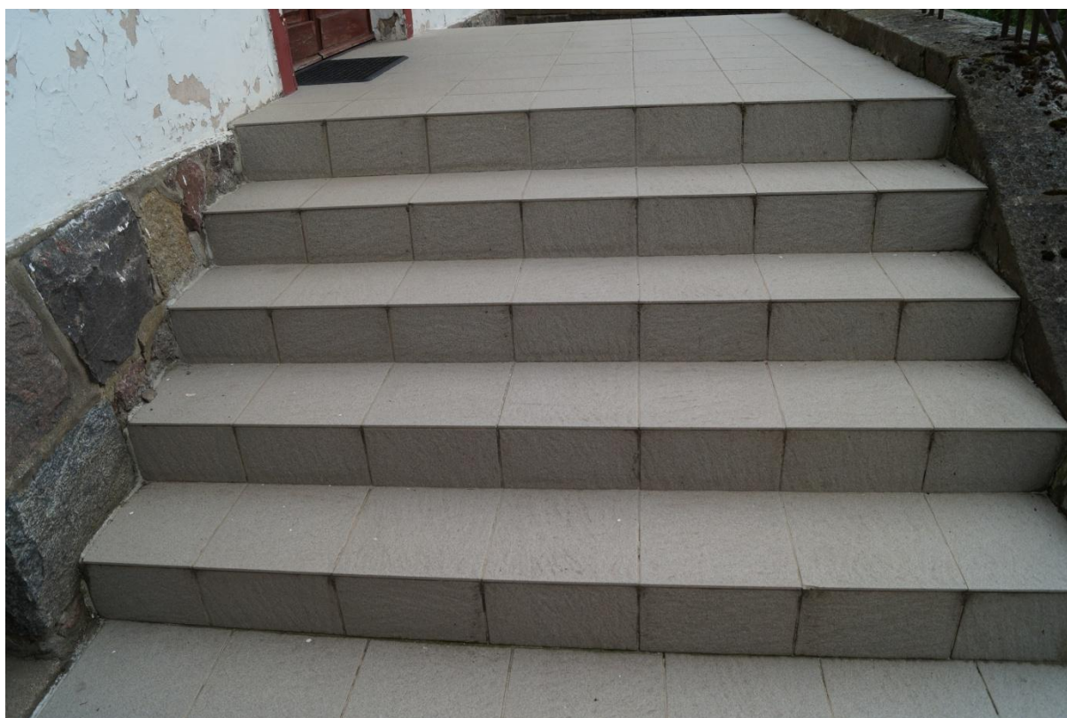
Fot. 5 (wyk. mgr W. Tomaszewski): Powierzchnię schodów lustrzanych obecnie w całości pokrywają kafle ceramiczne (gres).
