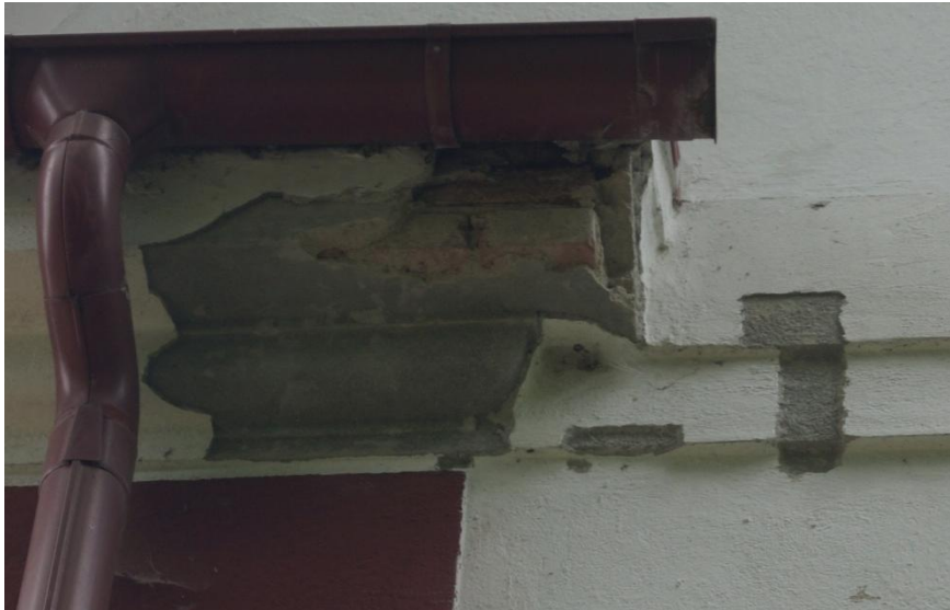
Fot. 81 i 82 (wyk. mgr W. Tomaszewski): Fotografia odkrywki wykonanej na powierzchni profilowanego gzymsu wraz ze wskazaniem miejsca pobrania próbek (elewacja południowa).
