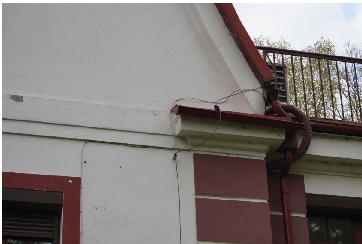
Fot. 19 i 20 (wyk. mgr W. Tomaszewski): Widok stanu zachowania odcinków profilowanych gzymsów na elewacji południowej. W kilku miejscach farba złuszcza się i odspaja. Zlokalizowano również pustki pod warstwami tynkarskimi.
