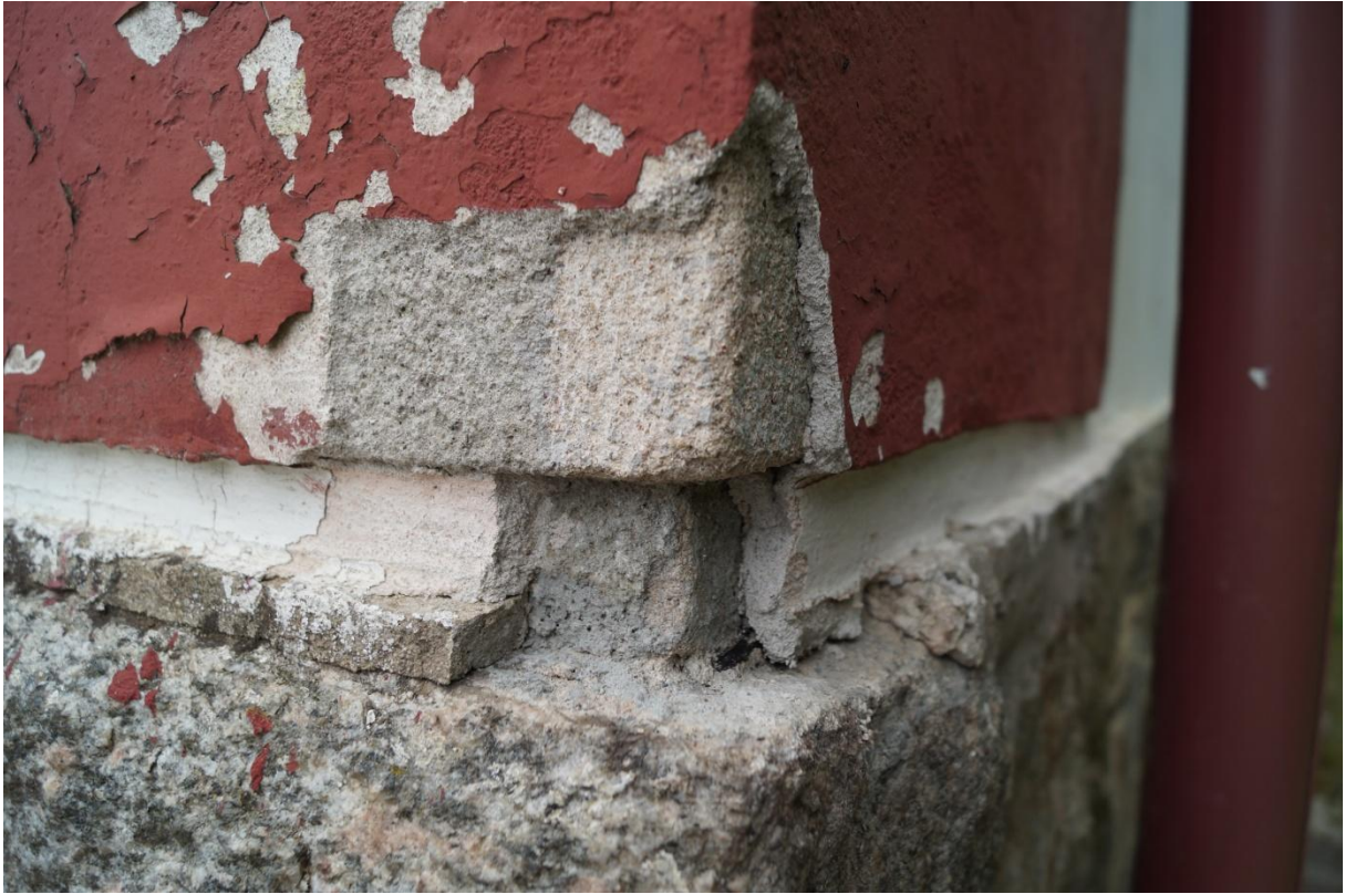
Fot. 77 (wyk. mgr W. Tomaszewski): Fotografia odkrywki wykonanej na powierzchni dekoracyjnego boniowania (narożnik południowo-zachodni budynku).
