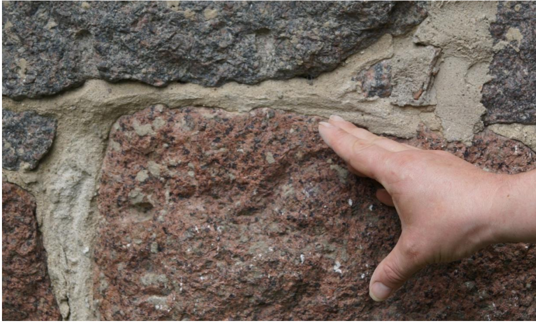
Fot. 69 (wyk. mgr W. Tomaszewski): Wskazanie odcinka oryginalnej spoiny pomiędzy blokami granitowymi oraz miejsce pobrania próbki do analizy. Pomimo częściowego wypłukania i zwietrzenia widoczny jest lekko obły sposób kształtowania. Lokalizacja: elewacja południowa.
