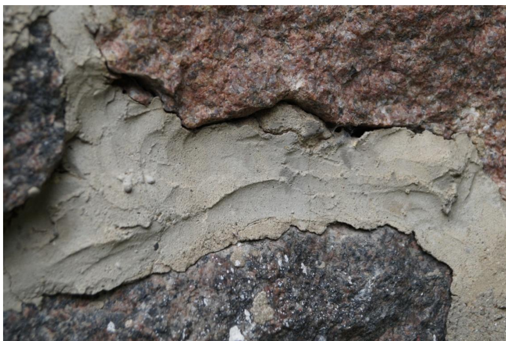
Fot. 50 i 51 (wyk. mgr W. Tomaszewski): Przykłady nieprofesjonalnych działań, mających tylko na celu doraźnie zamknięcie powstałych szczelin. Estetyka wykonania wtórnych spoin w wielu miejscach dalece odbiega od sztuki budowlanej.
