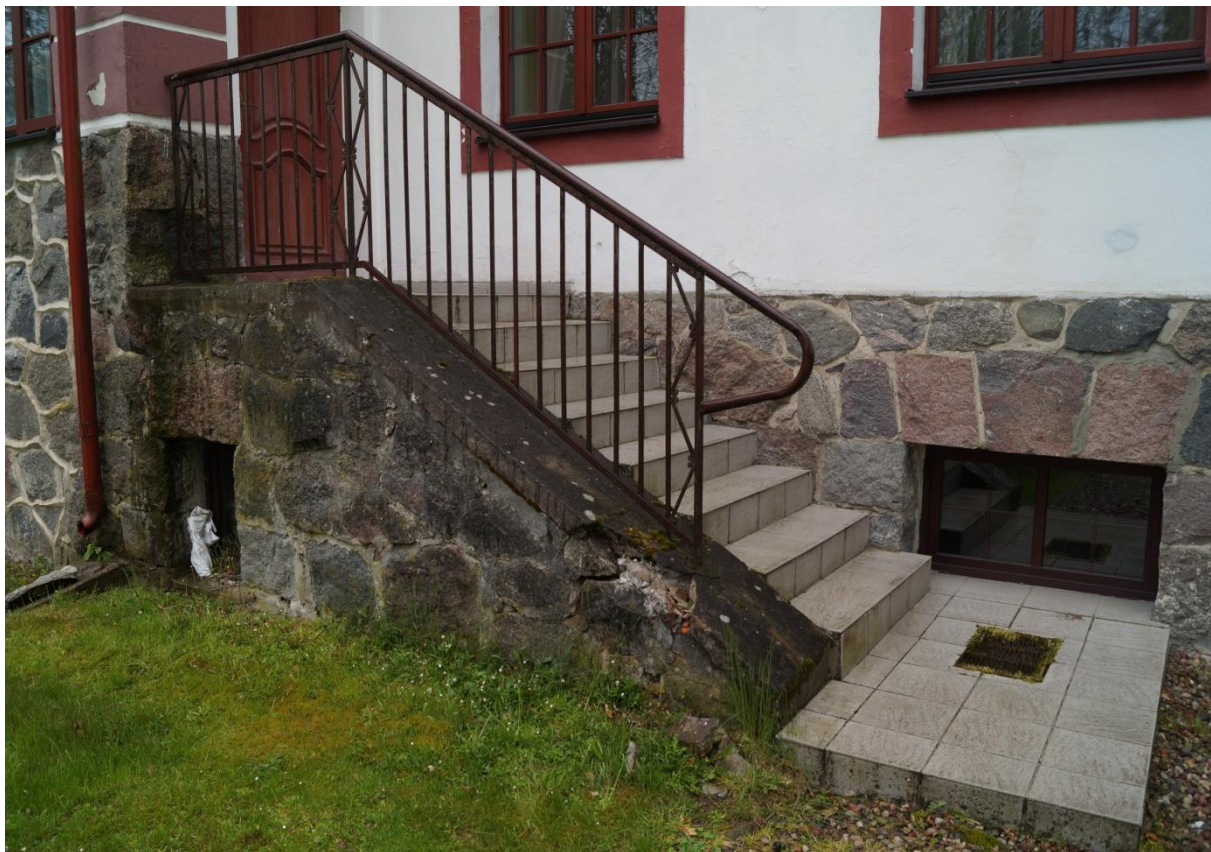
Fot. 32 i 33 (wyk. mgr W. Tomaszewski): Widok stanu zachowania schodów prowadzących do pomieszczenia werandy. Powierzchnię schodów obecnie w całości pokrywają kafle ceramiczne (gres). Widoczne jest uszkodzenie betonowej wylewki, w którą zakotwiona jest metalowa balustrada.
