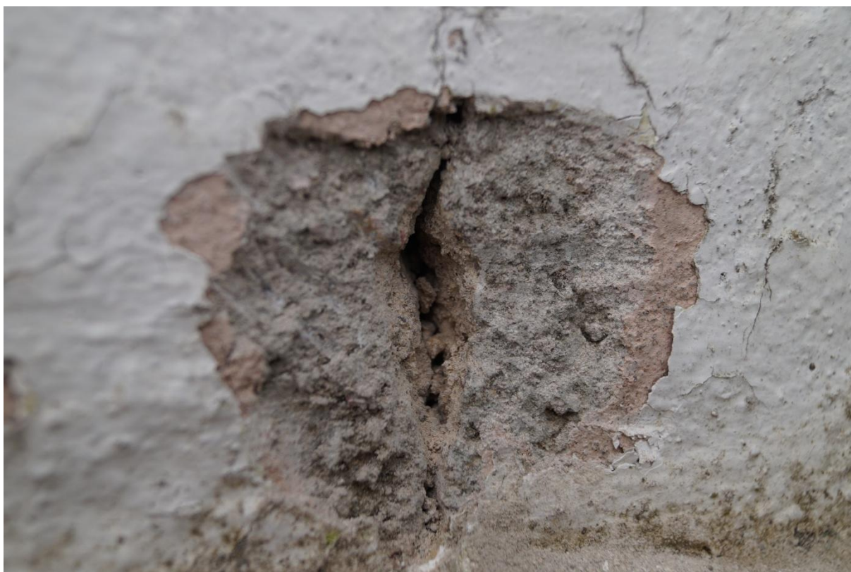
Fot. 74 (wyk. mgr W. Tomaszewski): Odkrywka wykonana samoczynnie w wybranym miejscu płaskiej powierzchni ściany.
