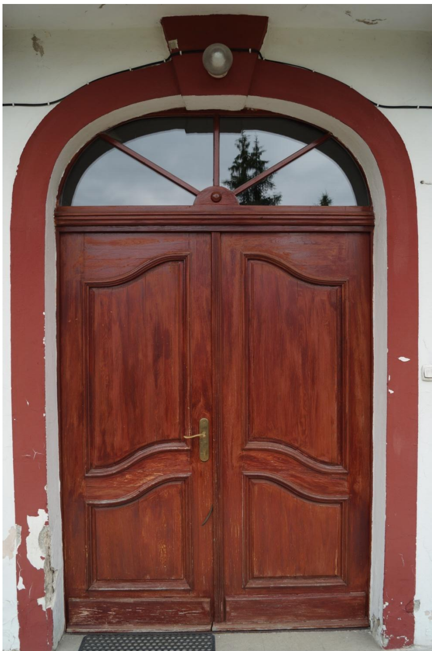
Fot. 53 (wyk. mgr W. Tomaszewski): Wtórne drzwi sosnowe prowadzące do budynku od strony schodów lustrzanych – elewacja zachodnia. Stan zachowania od strony zewnętrznej.
