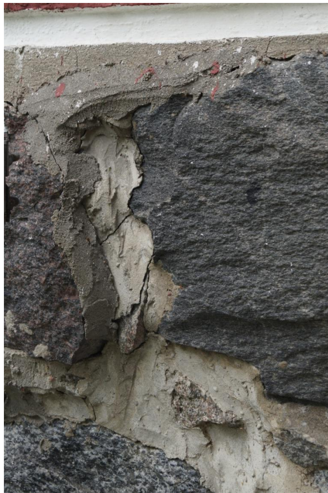
Fot. 50 i 51 (wyk. mgr W. Tomaszewski): Przykłady nieprofesjonalnych działań, mających tylko na celu doraźnie zamknięcie powstałych szczelin. Estetyka wykonania wtórnych spoin w wielu miejscach dalece odbiega od sztuki budowlanej.
