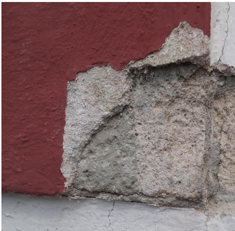
Fot. 79 (wyk. mgr W. Tomaszewski): Fotografia odkrywki wykonanej na powierzchni opaski okiennej (strona zachodnia).
