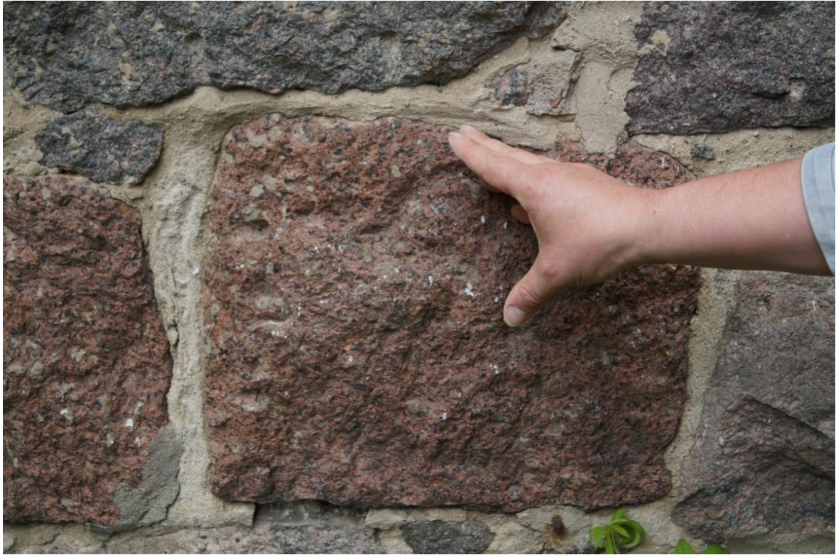
Fot. 40 (wyk. mgr W. Tomaszewski): Wskazanie odcinka oryginalnej spoiny na fragmencie elewacji wschodniej.
