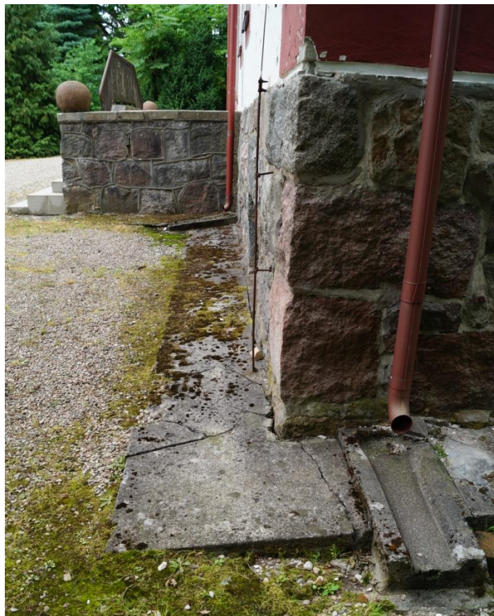
Fot. 12 (wyk. mgr W. Tomaszewski): Widok stanu zachowania betonowej opaski po stronie zachodniej budynku. Opaska jest w wielu miejscach spękana. Na jej powierzchni występują mikroorganizmy w postaci mchów i porostów.
