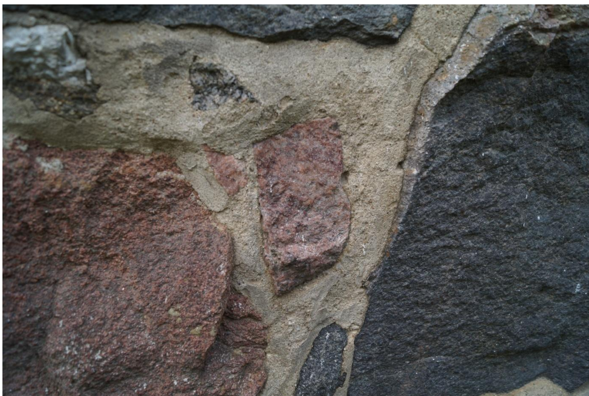
Fot. 47 (wyk. mgr W. Tomaszewski): Przykład oryginalnej spoiny na fragmencie elewacji południowej (j. w.).
