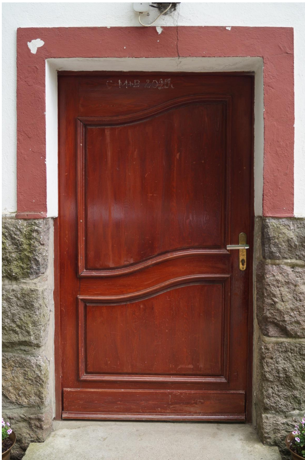
Fot. 54 (wyk. mgr W. Tomaszewski): Wtórne drzwi sosnowe prowadzące do budynku od strony elewacji północnej (wejście od strony kuchni). Stan zachowania od strony zewnętrznej.
