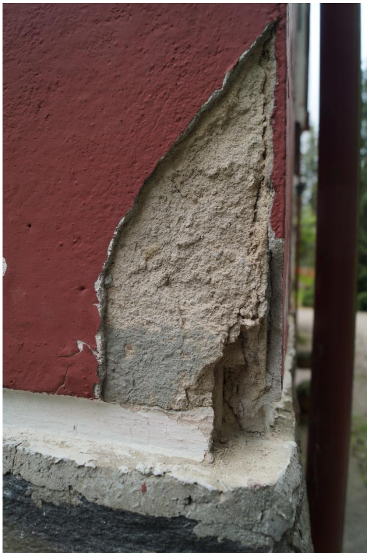
Fot. 78 (wyk. mgr W. Tomaszewski): Fotografia odkrywki wykonanej na powierzchni dekoracyjnego boniowania (narożnik północno-wschodni budynku).
