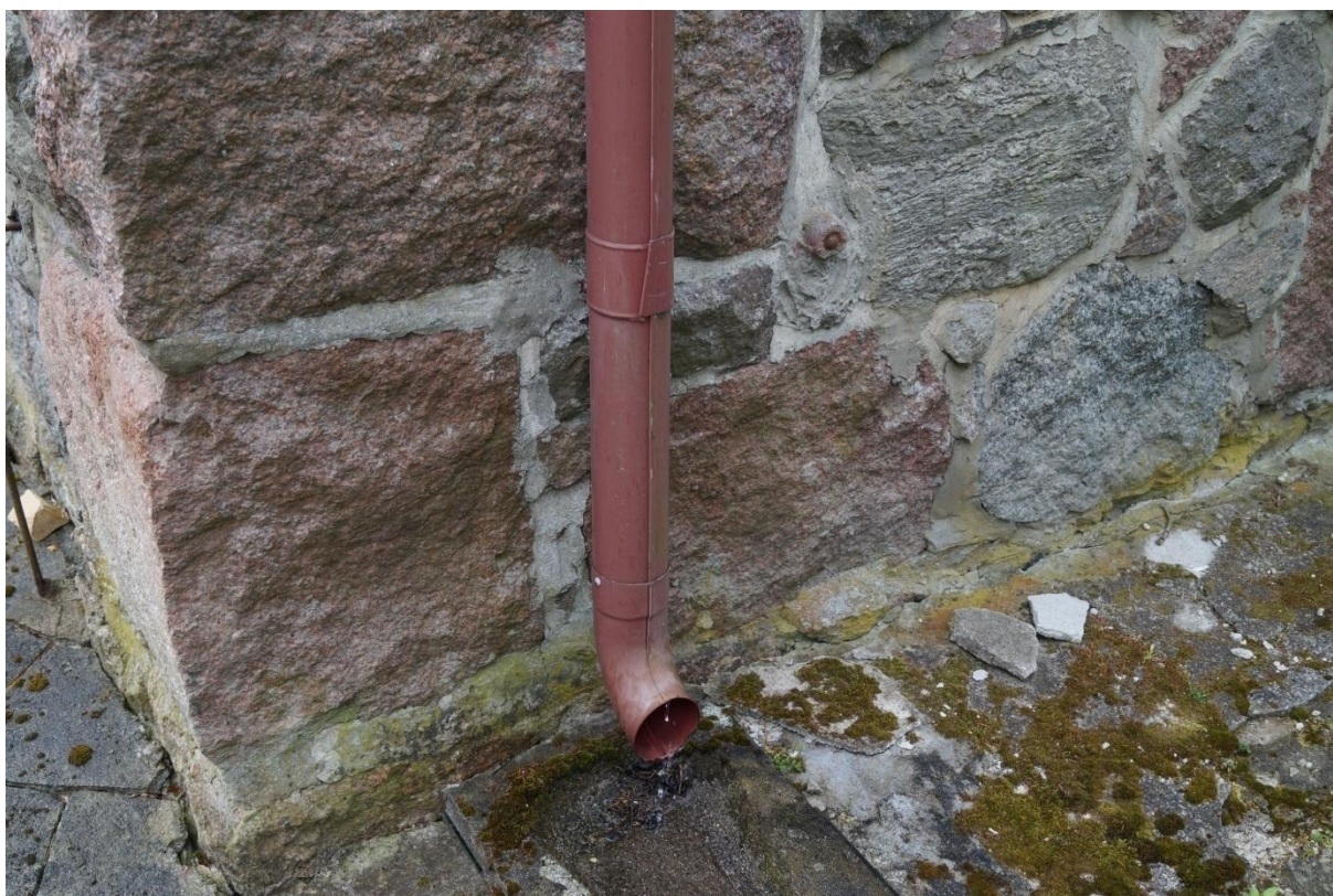
Fot. 48 (wyk. mgr W. Tomaszewski): Przykład zróżnicowanego spoinowania na wybranym fragmencie muru po stronie elewacji południowej. Na prawo od rynny w ścianie tkwi tzw. reper .
