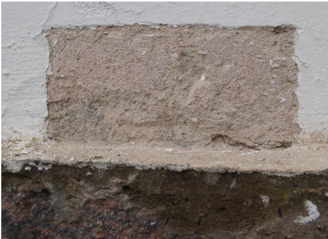
Fot. 73 (wyk. mgr W. Tomaszewski): Odkrywka wykonana w wybranym miejscu płaskiej powierzchni ściany.
