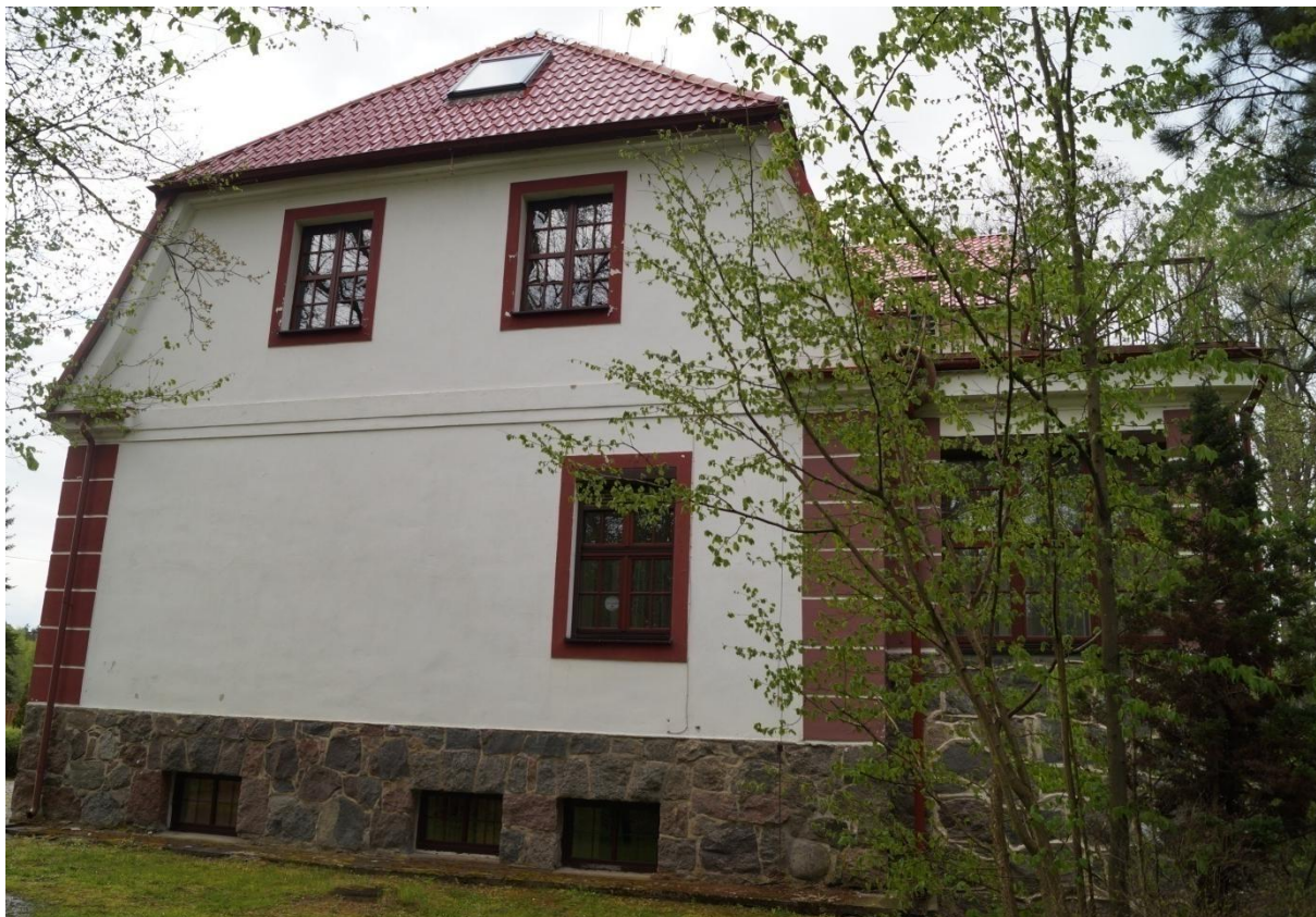
Fot. 21 (wyk. mgr W. Tomaszewski): Widok elewacji południowej ukazujący stan zachowania fragmentu kamiennego cokołu, opasek okiennych, narożnych boniowań oraz odcinków profilowanych gzymsów oddzielających kondygnację oraz obwodzących dach. Farba na elewacji w kilku miejscach złuszcza się i odpada. Zlokalizowano także pustki pod warstwami tynkarskimi.
