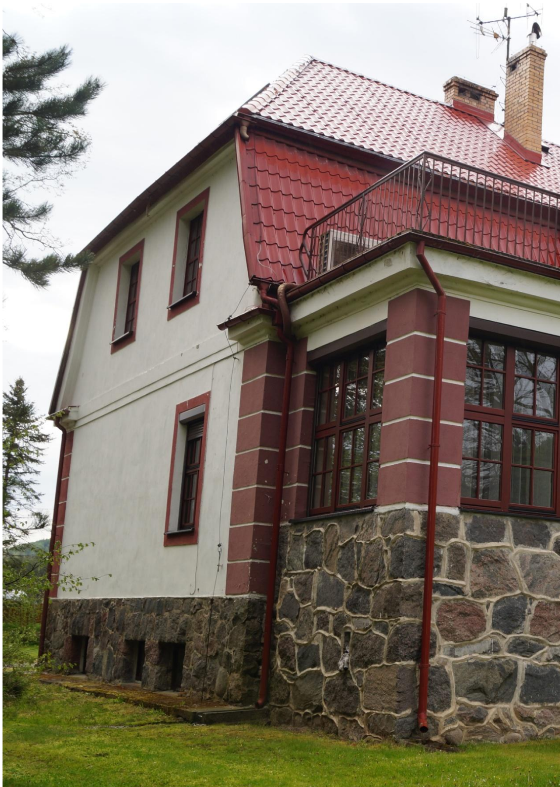
Fot. 23 (wyk. mgr W. Tomaszewski): Widok stanu zachowania narożnika południowo – wschodniego. Kamienne cokoły pod werandą są wtórnie wyspoinowane – w charakterystyczny ostry sposób ukształtowania spoin.
