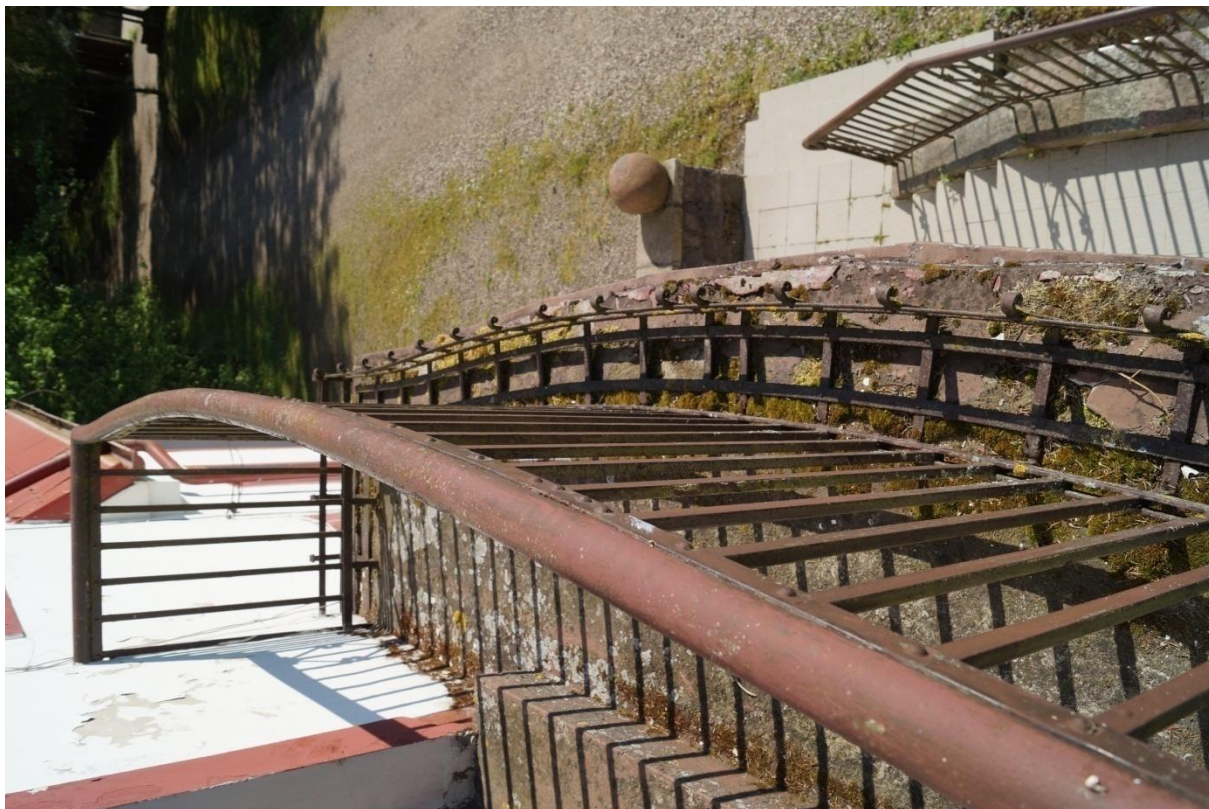
Fot. 62 i 63 (wyk. mgr W. Tomaszewski): Widok stanu zachowania oryginalnej stalowej balustrady osadzonej w rdzeniu płyty balkonowej – po zachodniej stronie elewacji.
