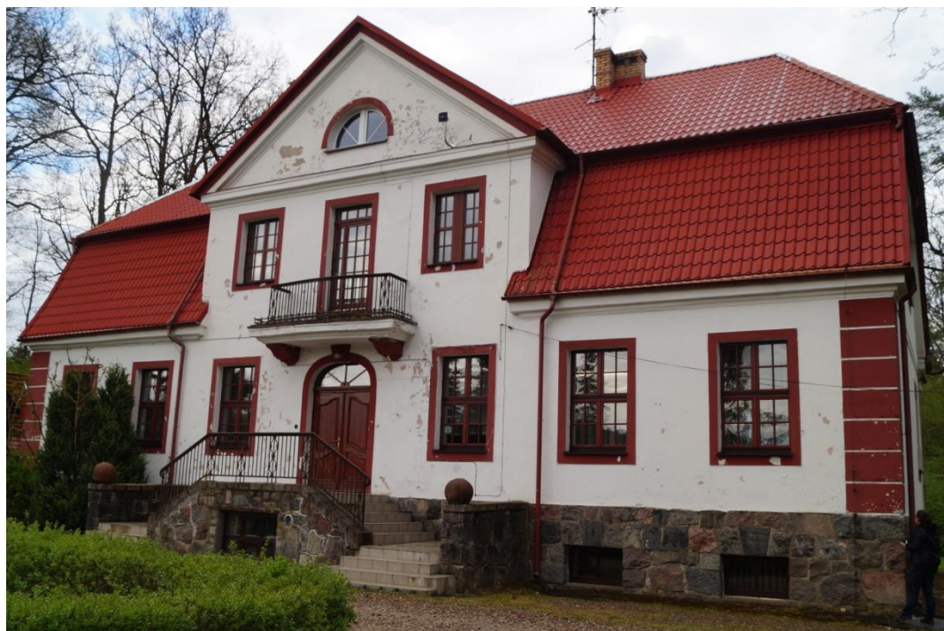
Fot. 2 i 3 (wyk. mgr W. Tomaszewski): Zestawienie ukośnych widoków ogólnych elewacji frontowej. Farba na elewacji w wielu miejscach złuszcza się i odpada. W wielu miejscach zlokalizowano pustki, odparzenia oraz wypłukania warstw tynkarskich. Jest to zachodnia strona elewacji, która jest najbardziej narażona na wiatry oraz zacinające deszcze – co potwierdza mieszkający w budynku Leśniczy.
