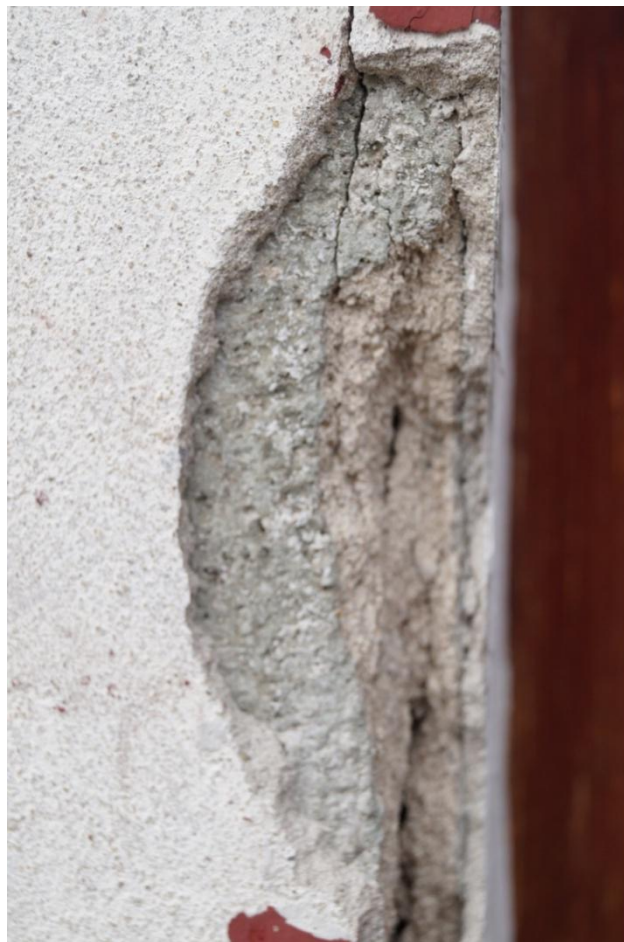
Fot. 81 (wyk. mgr W. Tomaszewski): Fotografia odkrytki wykonanej samoczynnie na powierzchni narożnika wnętrza wejściowej (portalu):
