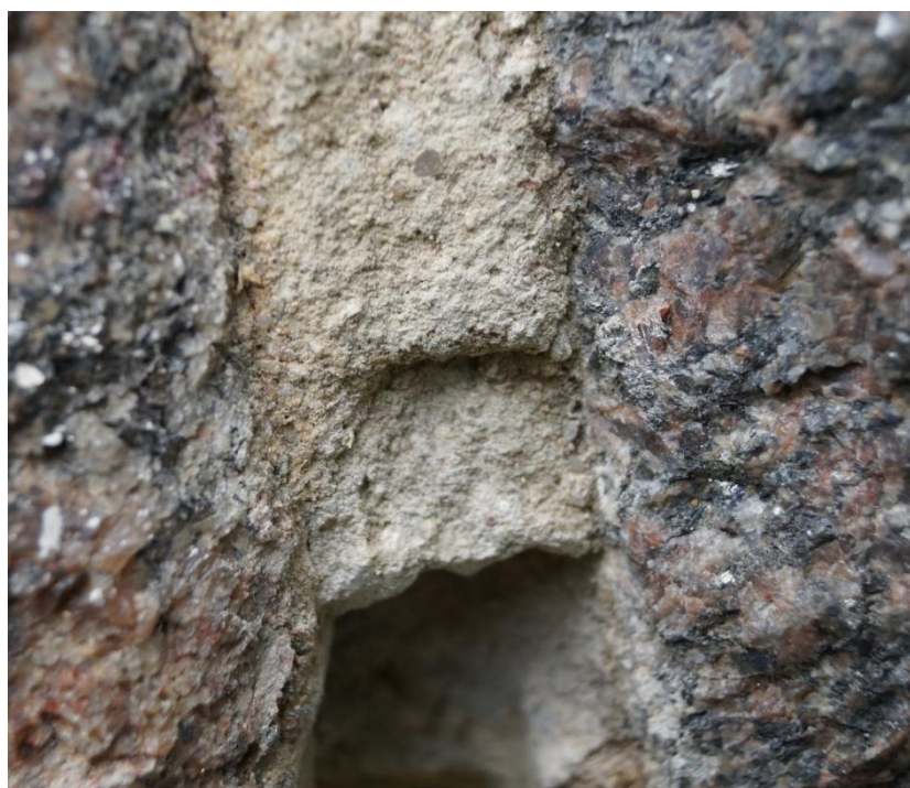
Fot. 67 i 68 (wyk. mgr W. Tomaszewski): Wskazanie odcinka oryginalnej spoiny pomiędzy blokami granitowymi oraz miejsce pobrania próbki do analizy. Pomimo częściowego wypłukania i zwietrzenia widoczny jest lekko obły sposób kształtowania. Lokalizacja: elewacja wschodnia (od strony stawu).
