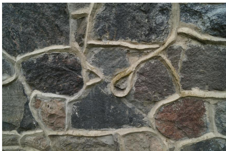
Fot. 44 i 45 (wyk. mgr W. Tomaszewski): Charakterystyczny ostry sposób ukształtowania spoin (j. w.).
