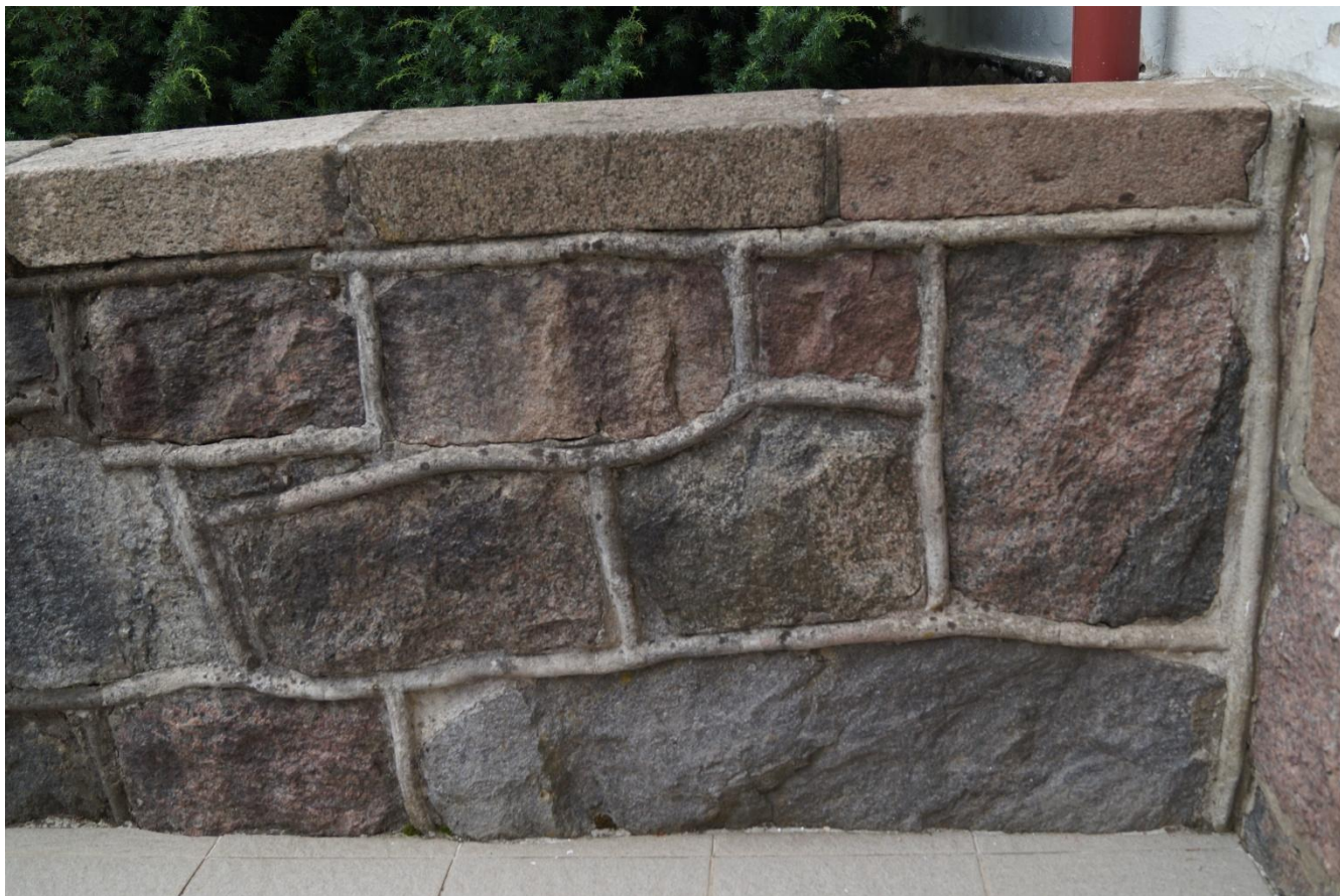
Fot. 52 (wyk. mgr W. Tomaszewski): Przykład wtórnego – charakterystycznego okrągłego spoinowania z użyciem i wykorzystaniem specjalnie ukształtowanego narzędzia. Ten fragment akurat został wykonany zgodnie ze sztuką budowlaną. Mur kamienny przy schodach lustrzanych po stronie zachodniej.
