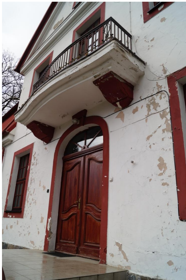
Fot. 8 i 9 (wyk. mgr W. Tomaszewski): Widok stanu zachowania wnęki wejściowej (portalu), wtórnych drzwi drewnianych oraz balkonu opartego na dekoracyjnych wspornikach. Farba na elewacji w wielu miejscach złuszcza się i odpada. W wielu miejscach zlokalizowano pustki, odparzenia oraz wypłukania warstw tynkarskich. Jest to zachodnia strona elewacji, która jest najbardziej narażona na wiatry oraz zacinające deszcze – co potwierdza mieszkający w budynku Leśniczy.
