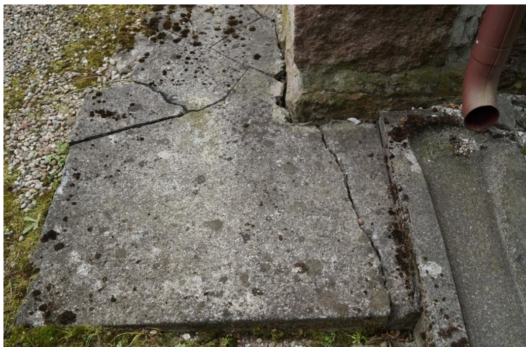
Fot. 13 (wyk. mgr W. Tomaszewski): Widok stanu zachowania betonowej opaski tuż przy południowo-zachodnim narożniku budynku. Opaska jest spękana. Na jej powierzchni występują mikroorganizmy w postaci mchów i porostów.
