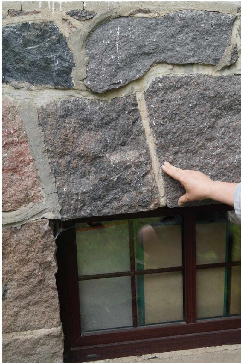
Fot. 66 (wyk. mgr W. Tomaszewski): Wskazanie odcinka oryginalnej spoiny pomiędzy blokami granitowymi. Lokalizacja: elewacja wschodnia (od strony stawu).
