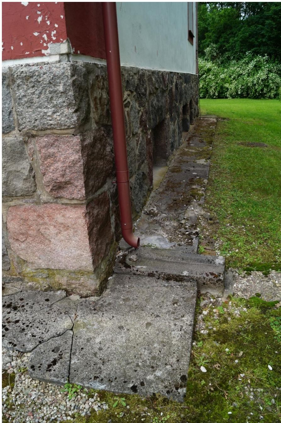
Fot. 16 (wyk. mgr W. Tomaszewski): Widok stanu zachowania betonowej opaski po stronie południowej budynku. Opaska jest w wielu miejscach spękana. Na jej powierzchni występują mikroorganizmy w postaci mchów i porostów.
