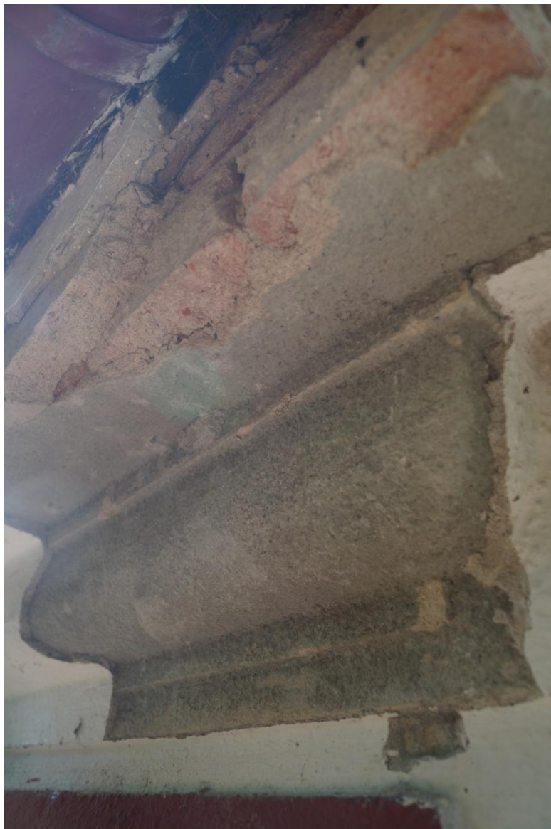
Fot. 83 (wyk. mgr W. Tomaszewski): Fotografia odkrywki wykonanej na powierzchni profilowanego gzymsu wraz ze wskazaniem miejsca pobrania próbek (elewacja południowa).
