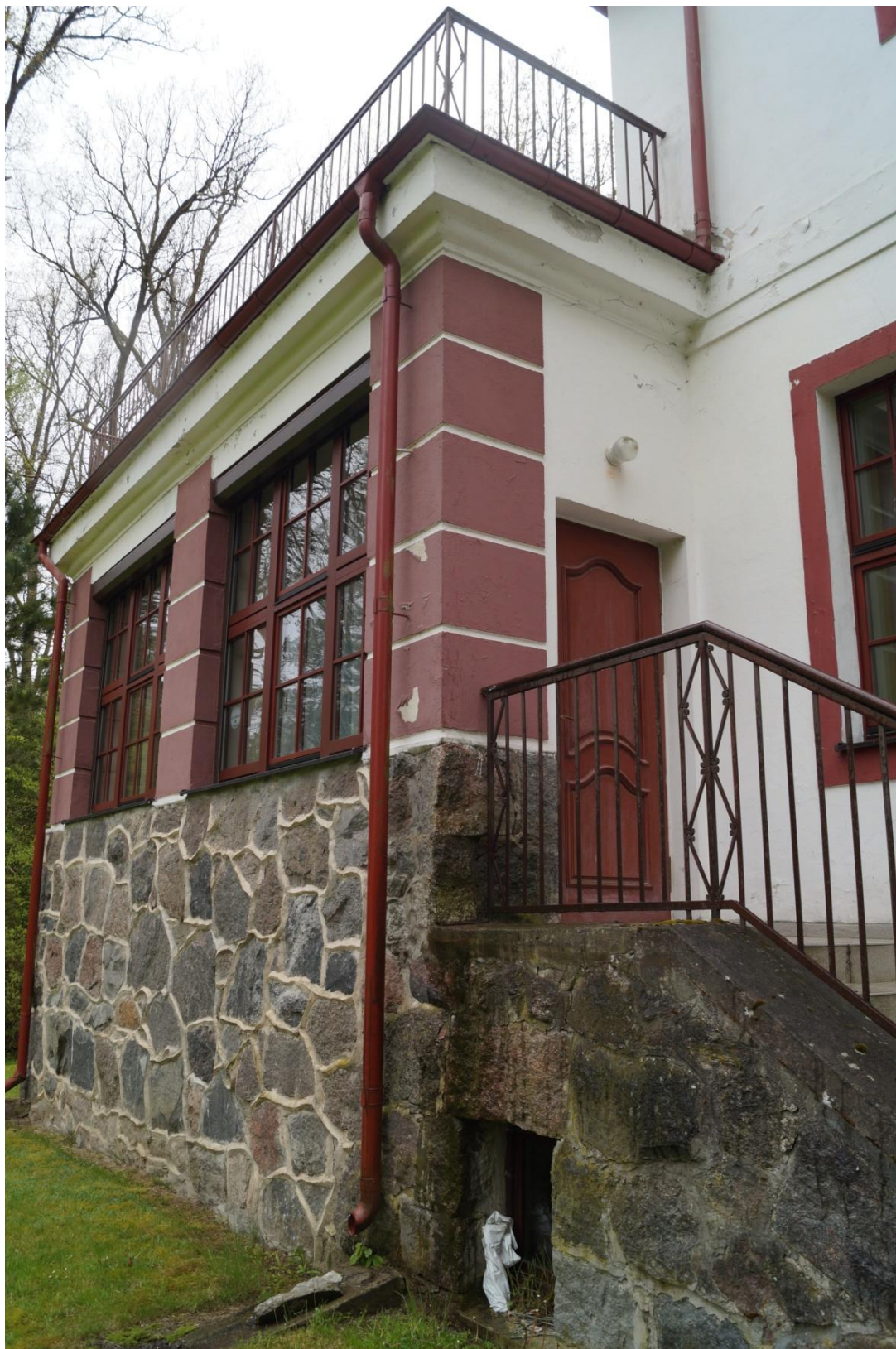
Fot. 30 (wyk. mgr W. Tomaszewski): Widok stanu zachowania werandy z tarasem. Kamienne cokoły pod werandą są wtórnie wypoinowane – w charakterystyczny ostry sposób ukształtowania spoin. Widoczne są także zacieki spowodowane nieszczelnością rynny – co jednocześnie sprzyja rozwojowi glonów na powierzchniach bloków granitowych. Metalowe balustrady na schodach oraz na tarasie są wtórne. Drewniane drzwi wejściowe pomieszczenia werandy są również wtórne.
