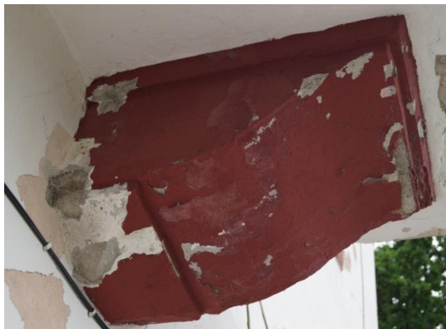
Fot. 90 i 91 (wyk. mgr W. Tomaszewski): Fotografie ukazujące miejsce pobrania próbek z betonowego wspornika (są tylko 2 sztuki) podtrzymującego płytę balkonową.
