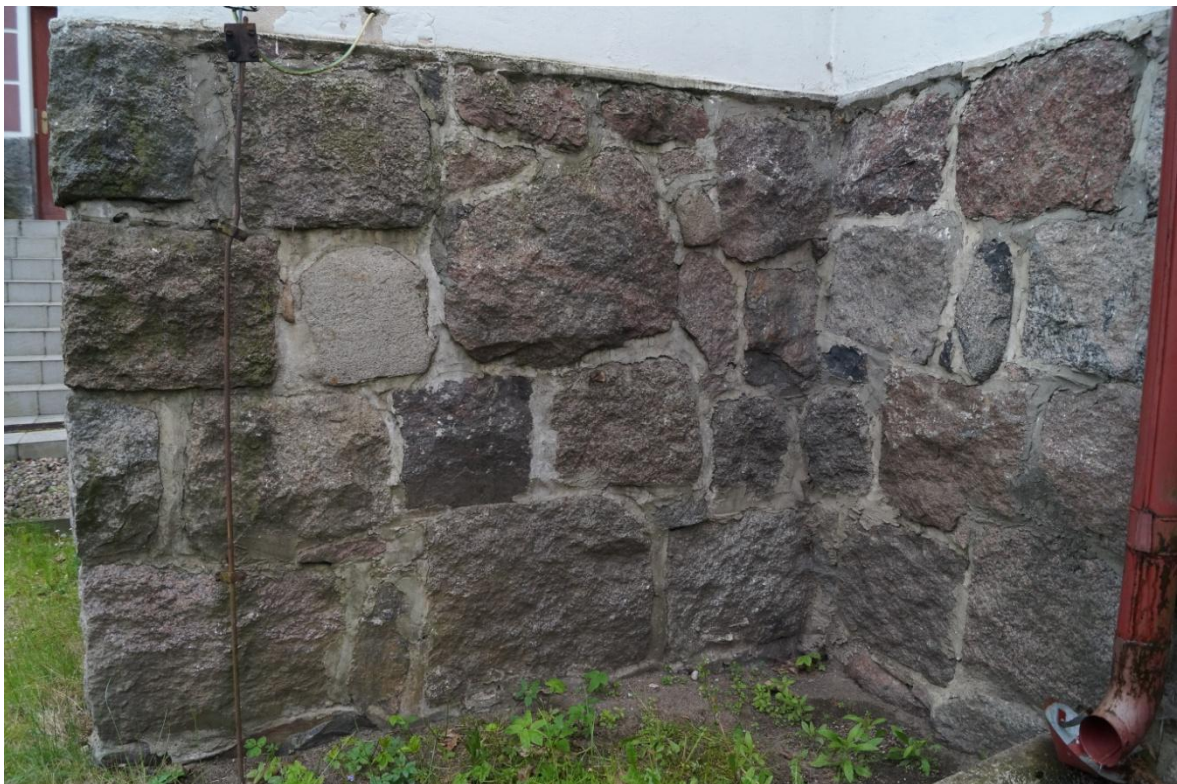
Fot. 41 (wyk. mgr W. Tomaszewski): Przykład występowania różnorodnych spoin na wybranym fragmencie powierzchni muru ceglanego (elewacja wschodnia).
