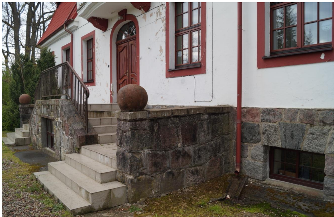
Fot. 4 (wyk. mgr W. Tomaszewski): Widok stanu zachowania wybranych odcinków kamiennych cokołów, schodów lustrzanych flankowanych granitowymi kulami oraz metalowej balustrady.
