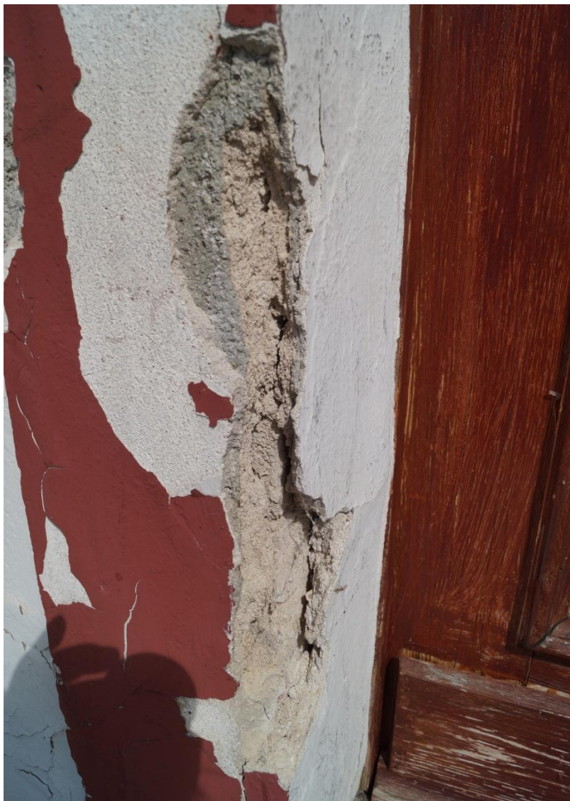
Fot. 80 (wyk. mgr W. Tomaszewski): Fotografia odkrywki wykonanej samoczynnie na powierzchni narożnika wnęki wejściowej (portalu):
