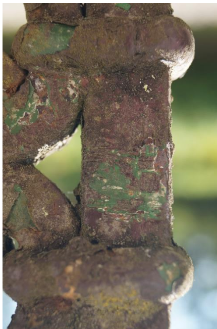
Fot. 93 i 94 (wyk. mgr W. Tomaszewski): Widok zestarzałych powłok malarskich obecnych na powierzchniach balustrad oraz miejsce wykonania odkrywek warstw kolorystycznych.
