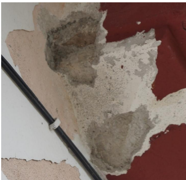
Fot. 90 i 91 (wyk. mgr W. Tomaszewski): Fotografie ukazujące miejsce pobrania próbek z betonowego wspornika (są tylko 2 sztuki) podtrzymującego płytę balkonową.
