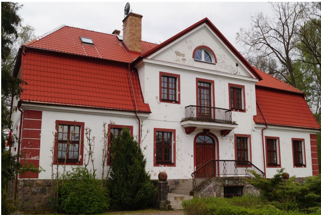
Fot. 2 i 3 (wyk. mgr W. Tomaszewski): Zestawienie ukośnych widoków ogólnych elewacji frontowej. Farba na elewacji w wielu miejscach złuszcza się i odpada. W wielu miejscach zlokalizowano pustki, odparzenia oraz wypłukania warstw tynkarskich. Jest to zachodnia strona elewacji, która jest najbardziej narażona na wiatry oraz zacinające deszcze – co potwierdza mieszkający w budynku Leśniczy.
