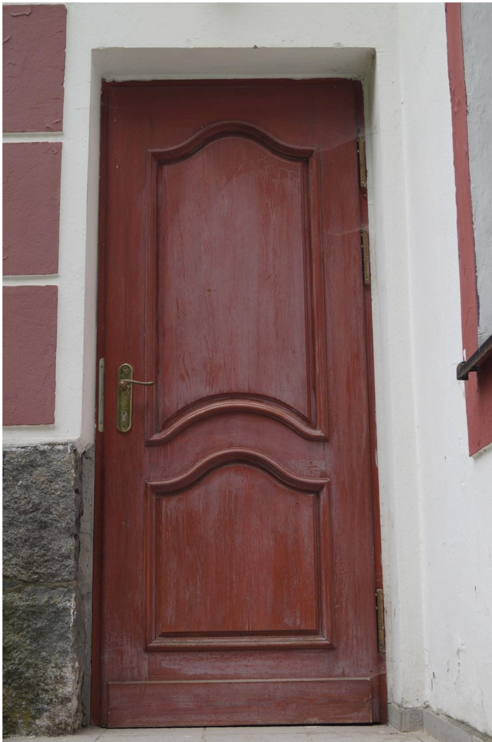
Fot. 55 (wyk. mgr W. Tomaszewski): Wtórne drzwi sosnowe prowadzące do werandy od strony elewacji wschodniej. Stan zachowania od strony zewnętrznej.
