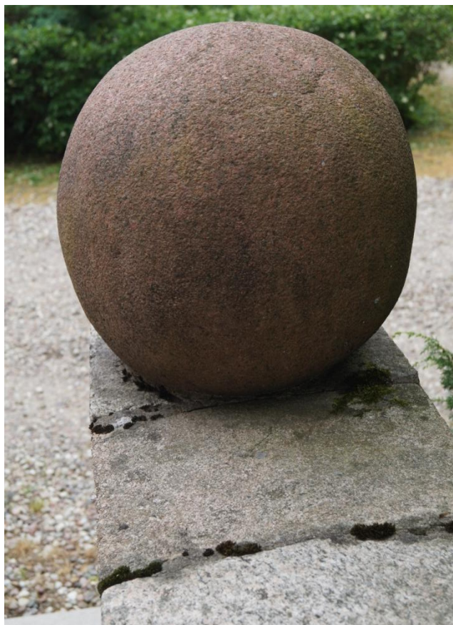
Fot. 6 i 7 (wyk. mgr W. Tomaszewski): Stan zachowania granitowych kul flankujących schody lustrzane .
