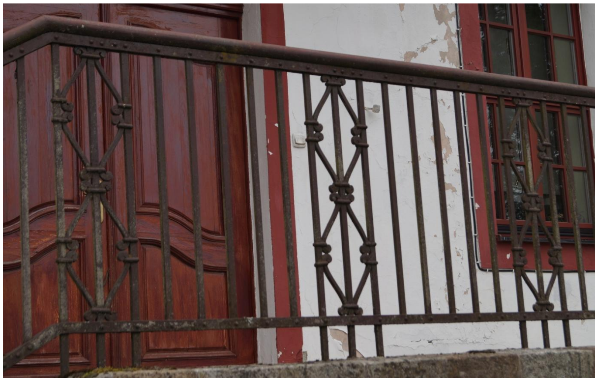
Fot. 56 i 57 (wyk. mgr W. Tomaszewski): Widok stanu zachowania oryginalnych stalowych balustrad osadzonych w murze kamiennym przy schodach lustrzanych – po zachodniej stronie elewacji.
