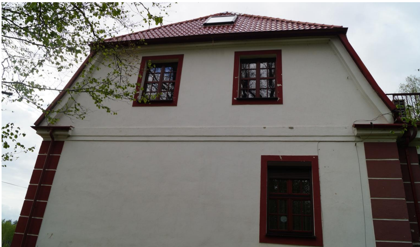
Fot. 17 i 18 (wyk. mgr W. Tomaszewski): Widok elewacji południowej, ukazujący stan zachowania fragmentu kamiennego cokotu, opasek okiennych, narożnych boniowań oraz odcinków profilowanych gzymsów oddzielających kondygnację oraz obwodzących dach. Farba na elewacji w kilku miejscach złuszcza się i odpada. Zlokalizowano także nieliczne pustki pod warstwami tynkarskimi.
