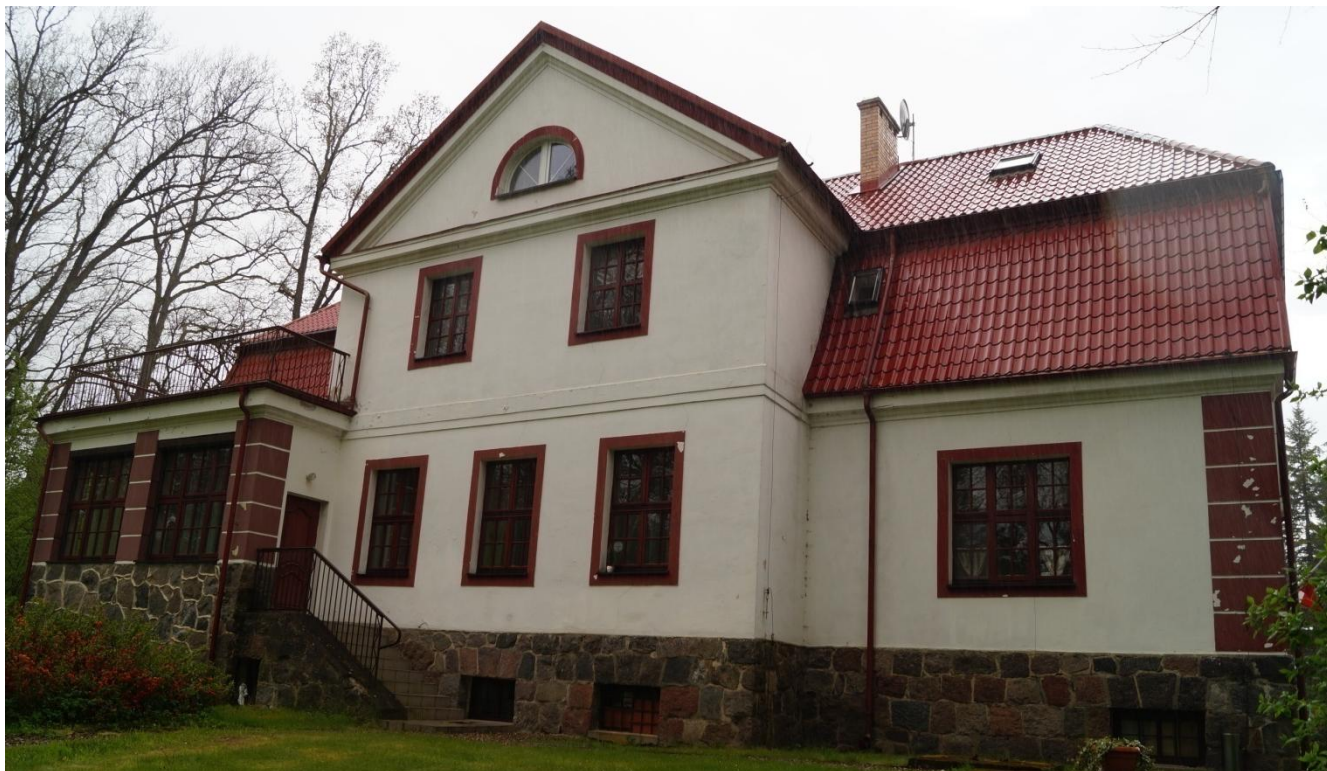
Fot. 26 i 27 (wyk. mgr W. Tomaszewski): Widok elewacji wschodniej ukazujący stan zachowania odcinka kamiennego cokotu, opasek okiennych, narożnych boniowań oraz odcinków profilowanych gzymsów oddzielających kondygnację oraz obwodzących dach. Farba na elewacji w kilku miejscach złuszcza się i odpada. Zlokalizowano także pustki pod warstwami tynkarskimi oraz drobne rysy.
