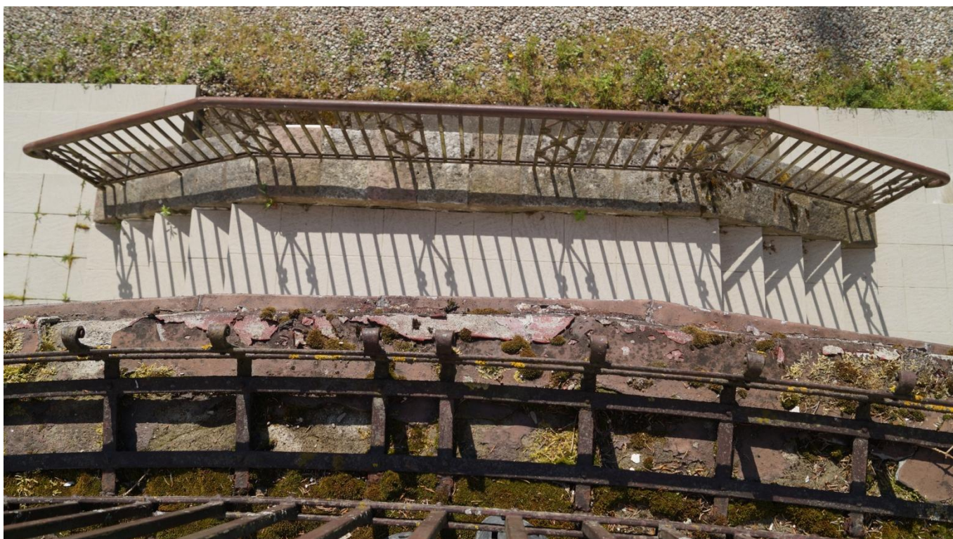
Fot. 61 (wyk. mgr W. Tomaszewski): Widok stanu zachowania oryginalnych stalowych balustrad osadzonych w rdzeniu płyty balkonowej oraz murze kamiennym przy schodach lustrzanych – po zachodniej stronie elewacji.
