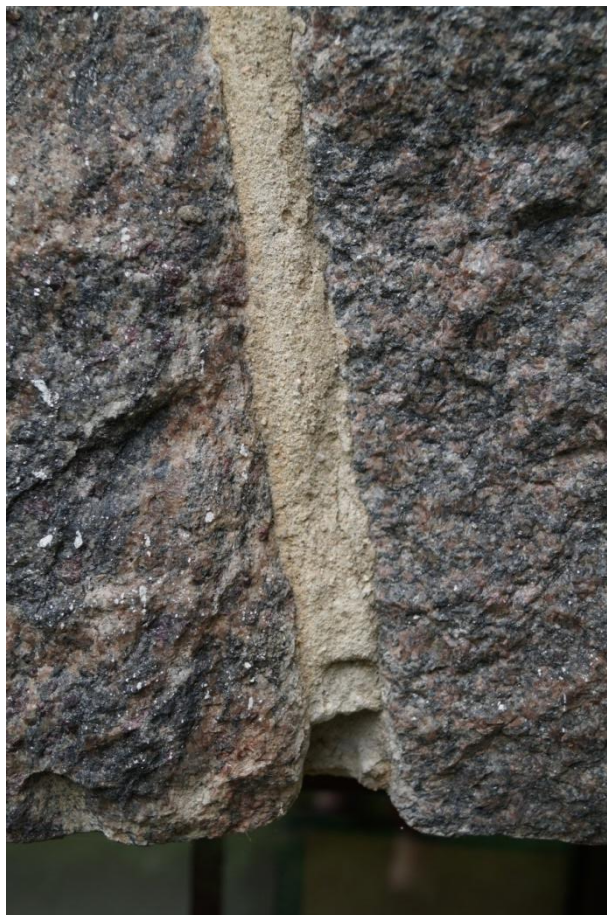
Fot. 67 i 68 (wyk. mgr W. Tomaszewski): Wskazanie odcinka oryginalnej spoiny pomiędzy blokami granitowymi oraz miejsce pobrania próbki do analizy. Pomimo częściowego wypłukania i zwietrzenia widoczny jest lekko obły sposób kształtowania. Lokalizacja: elewacja wschodnia (od strony stawu).
