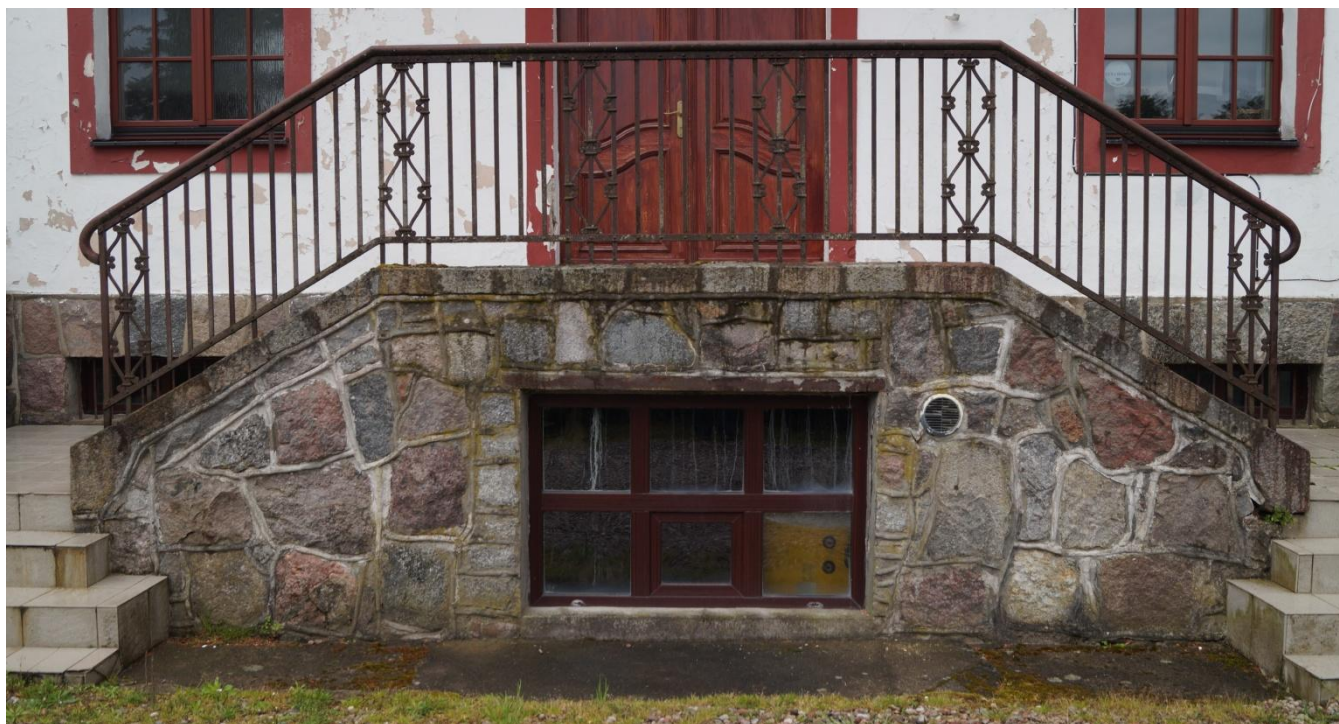
Fot. 56 i 57 (wyk. mgr W. Tomaszewski): Widok stanu zachowania oryginalnych stalowych balustrad osadzonych w murze kamiennym przy schodach lustrzanych – po zachodniej stronie elewacji.
