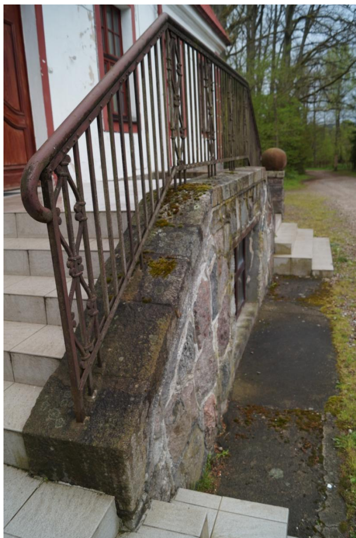
Fot. 58 i 59 (wyk. mgr W. Tomaszewski): Widok stanu zachowania oryginalnych stalowych balustrad osadzonych w murze kamiennym przy schodach lustrzanych – po zachodniej stronie elewacji.
