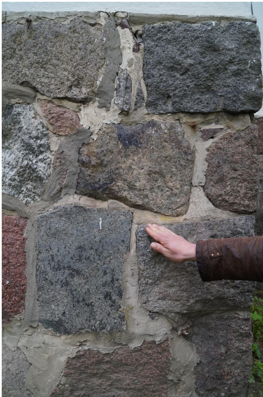
Fot. 42 (wyk. mgr W. Tomaszewski): Wskazanie odcinka oryginalnej spoiny na fragmencie elewacji północnej.
