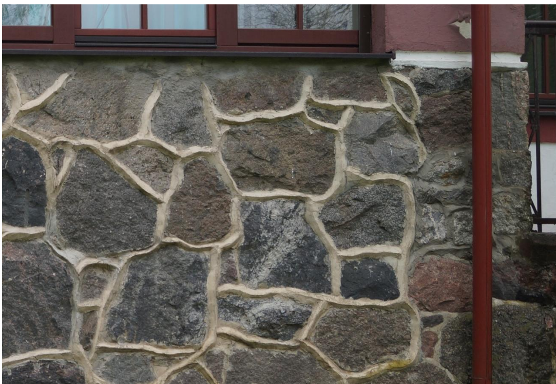
Fot. 28 i 29 (wyk. mgr W. Tomaszewski): Widok stanu zachowania werandy z tarasem. Kamienne cokoły pod werandą są wtórnie wyspoinowane – w charakterystyczny ostry sposób ukształtowania spoin.
