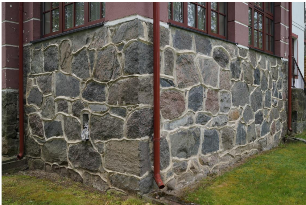
Fot. 43 (wyk. mgr W. Tomaszewski): Przykład wtórnego – aczkolwiek jednorodnego sposobu spoinowania.
