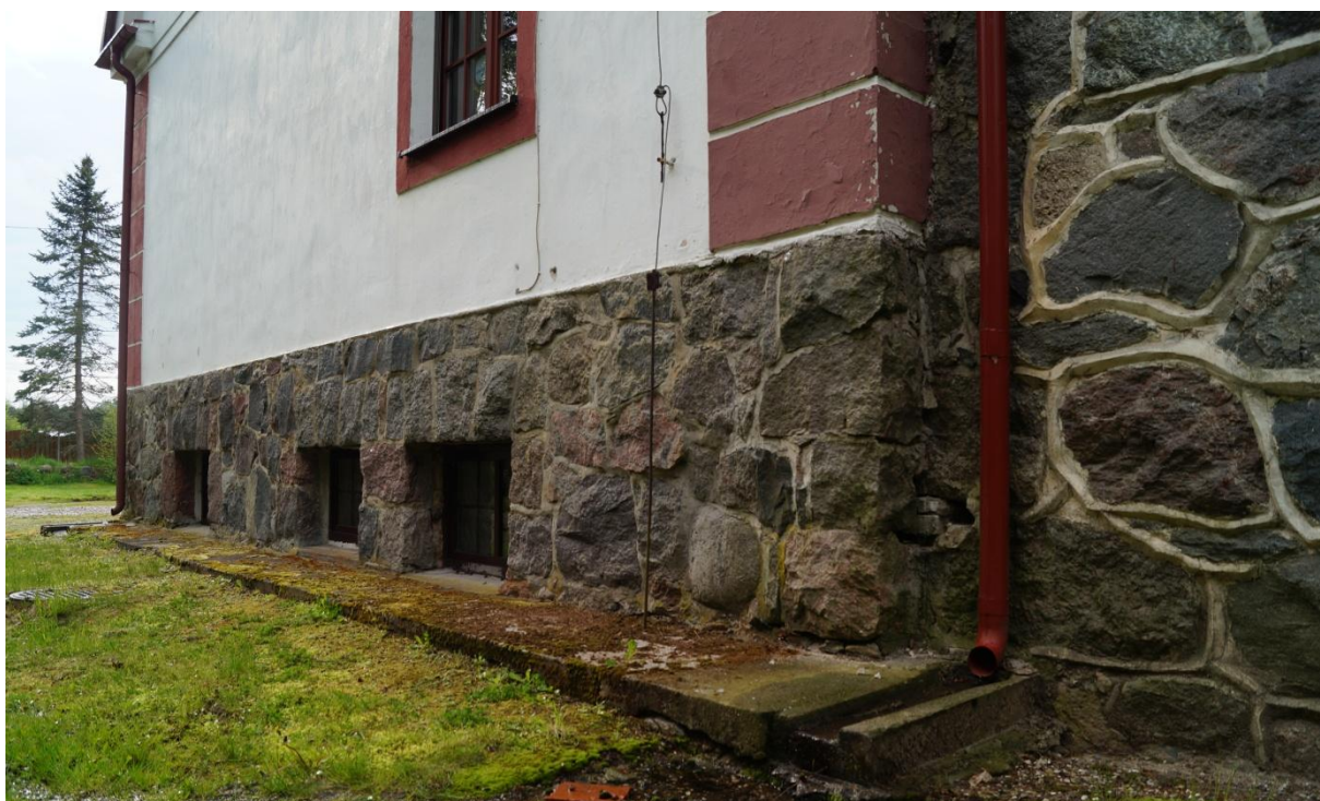
Fot. 22 (wyk. mgr W. Tomaszewski): Widok ukazujący stan zachowania odcinka kamiennego cokołu oraz betonowej wylewki pokrytej mchami i porostami.
