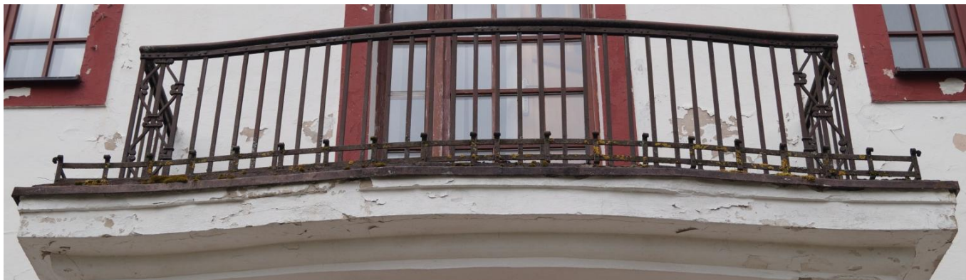
Fot. 60 (wyk. mgr W. Tomaszewski): Widok stanu zachowania oryginalnej stalowej balustrady osadzonej w rdzeniu płyty balkonowej – po zachodniej stronie elewacji.
