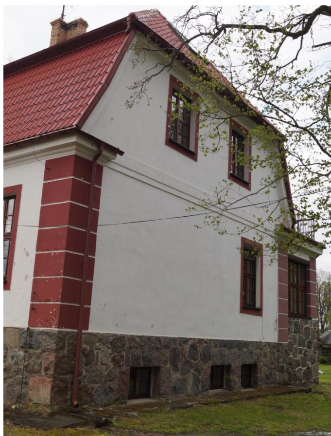
Fot 15 (wyk. mgr W. Tomaszewski): Ogólny widok elewacji południowej, ukazujący stan zachowania fragmentu kamiennego cokołu, opasek okiennych, narożnych boniowań oraz odcinków profilowanych gzymsów oddzielających kondygnację oraz obwodzących dach. Farba na elewacji w kilku miejscach złuszcza się i odpada. Zlokalizowano także nieliczne pustki pod warstwami tynkarskimi. Jest to najprostsza elewacja pod względem podziałów architektonicznych.
