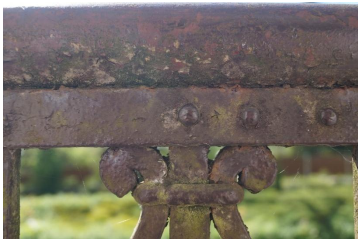
Fot. 93 i 94 (wyk. mgr W. Tomaszewski): Widok zestarzałych powłok malarskich obecnych na powierzchniach balustrad oraz miejsce wykonania odkrywek warstw kolorystycznych.
